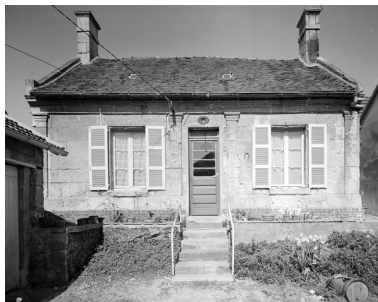
Elévation antérieure. Phot. Jean-Michel Perrin IVR22_19856000558V
