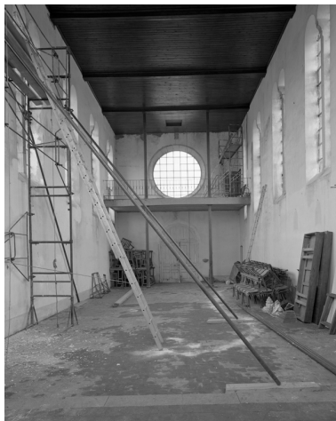
Vue intérieure de la nef (en cours de restauration) depuis le chœur vers l'entrée. Phot. Thierry Lefébure IVR22_19910201998V
