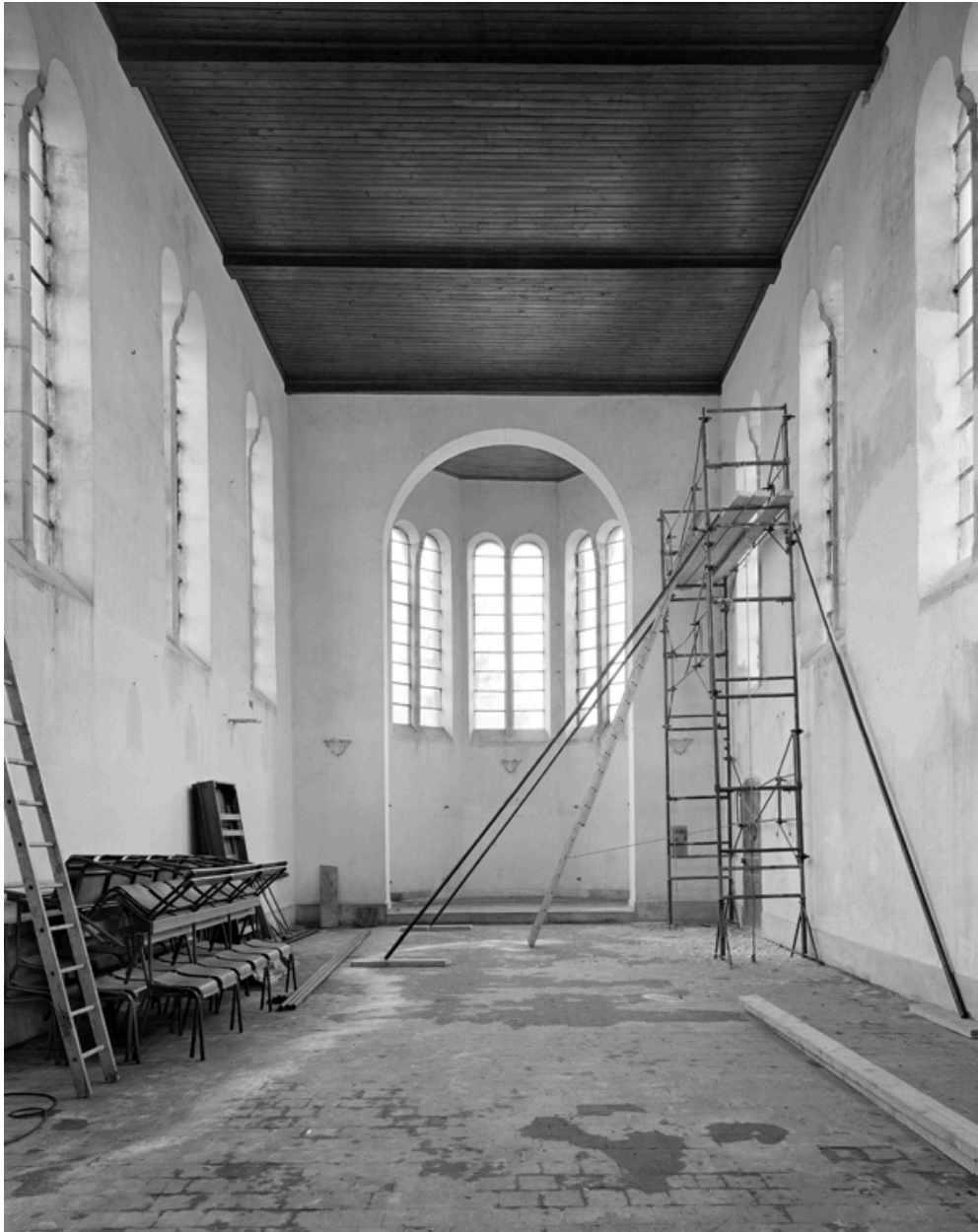
Vue intérieure (en cours de restauration), depuis l'entrée vers le chœur.
