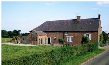
Vue générale depuis le nord-ouest. Phot. Thierry Lefébure IVR22_19930200852VA
