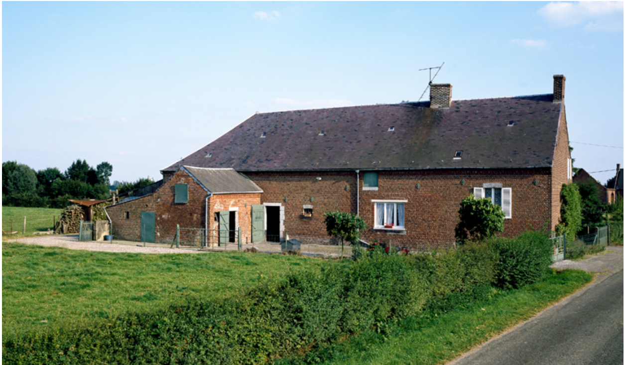
Vue générale depuis le nord-ouest.
