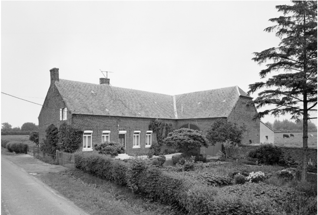
Vue générale depuis le sud-ouest.
