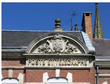
Détail du fronton de la façade sur rue.
