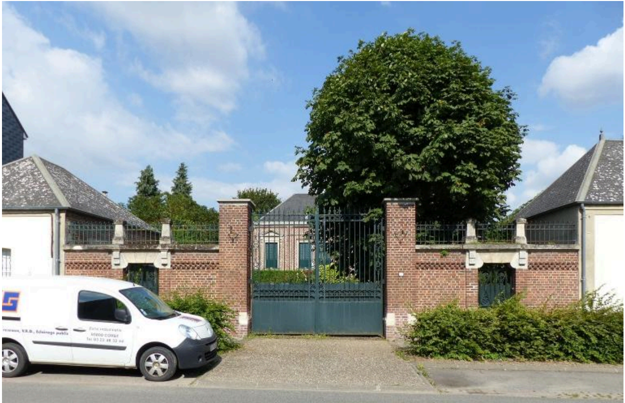
Vue de situation depuis la rue.
