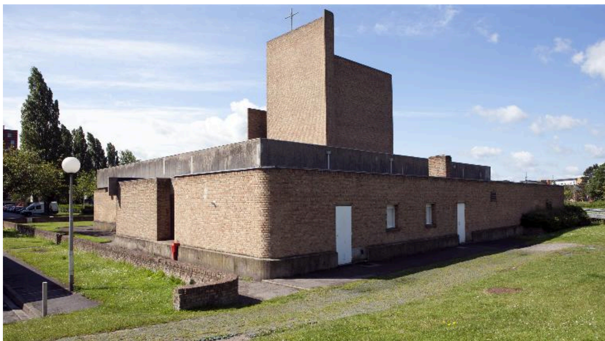
Élévation nord-est de l'église.
