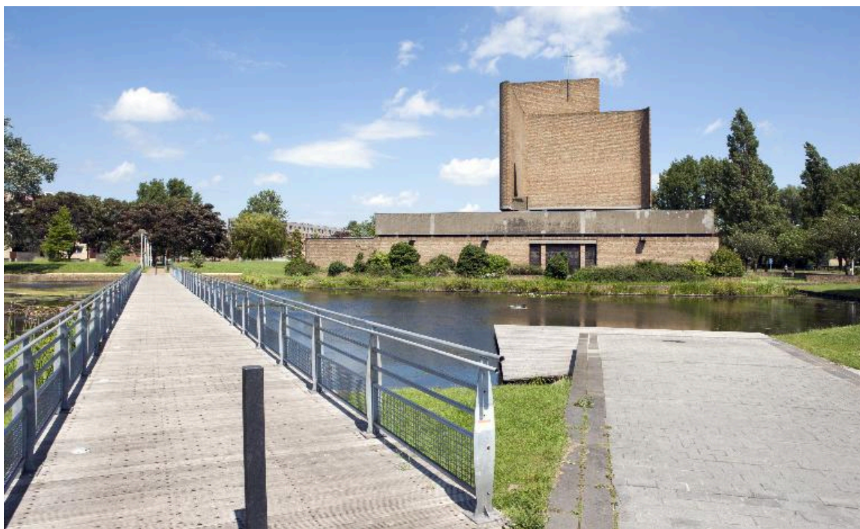
Élévation ouest de l'église, avec le pont et l'embarcadère du bassin.
