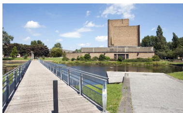
Élévation ouest de l'église, avec le pont et l'embarcadère du bassin. Phot. Pierre Thibaut IVR31_20155900419NUCA
