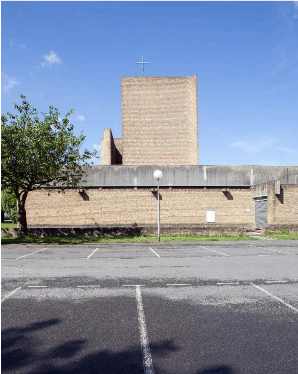
Élévation est de l'église.
