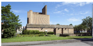
Élévation sud de l'église. Phot. Pierre Thibaut IVR31_20155900413NUCA
