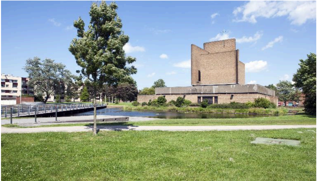
Élévation ouest de l'église avec le parc attenant.
