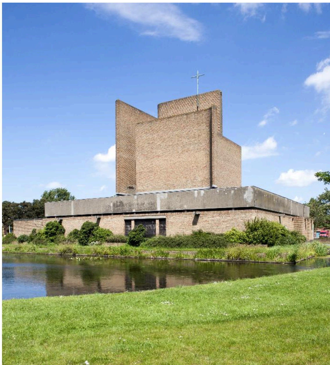
Élévation sud ouest de l'église avec le bassin.
