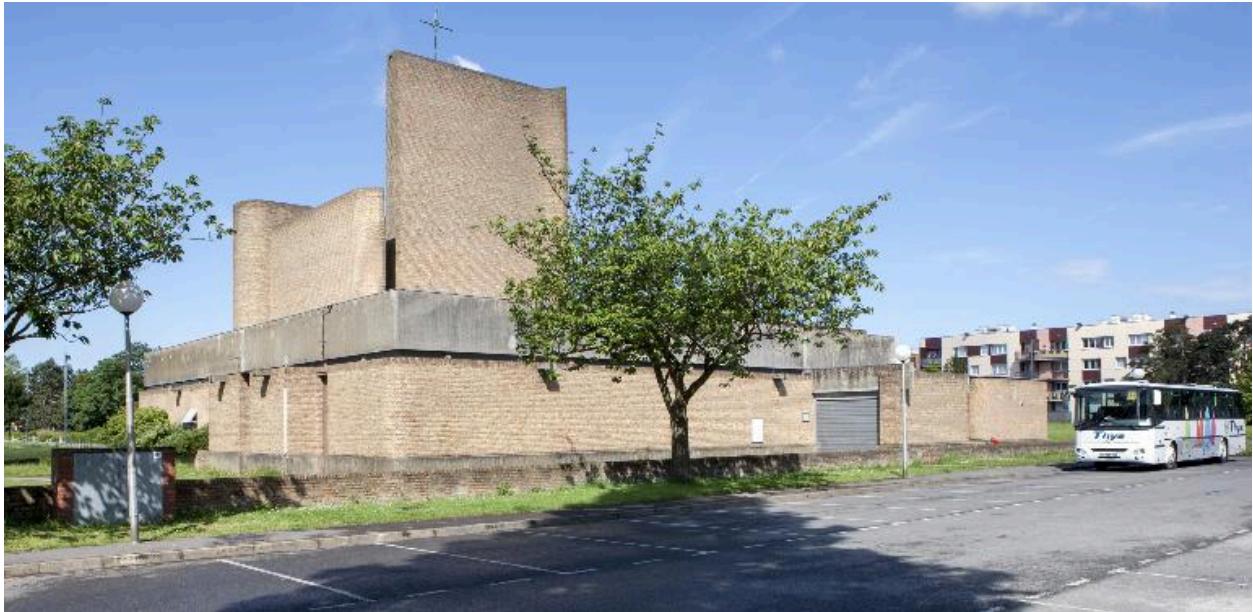
Élévation sud est de l'église avec son parvis.
