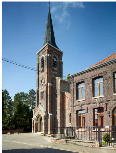
Vue générale. Phot. Pierre Thibaut IVR31_20155901592NUCA
