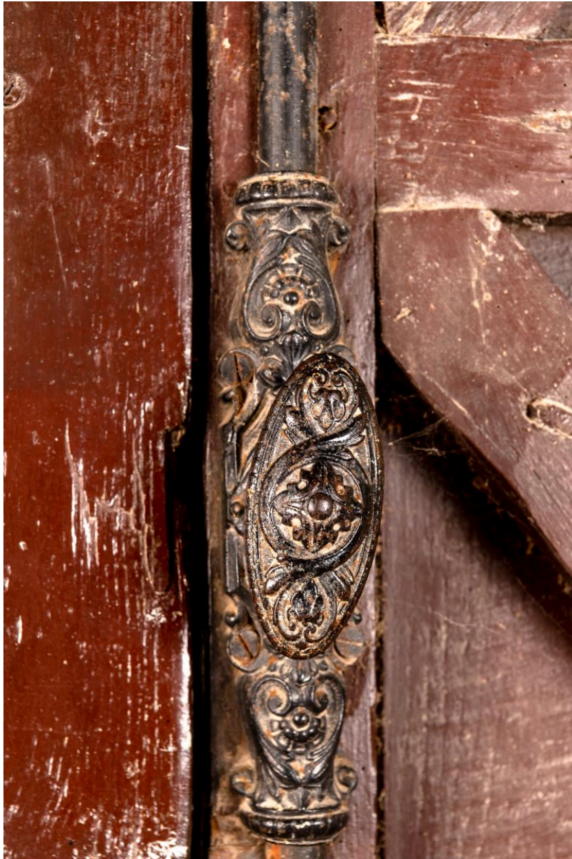
Porte d'entrée, détail des ferronneries, 19e siècle.
