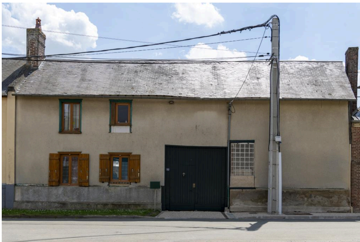
Logis sur rue avec entrée charretière et grange (porte à engranger comblée), n°32 Grande Rue, vue depuis le nord.
