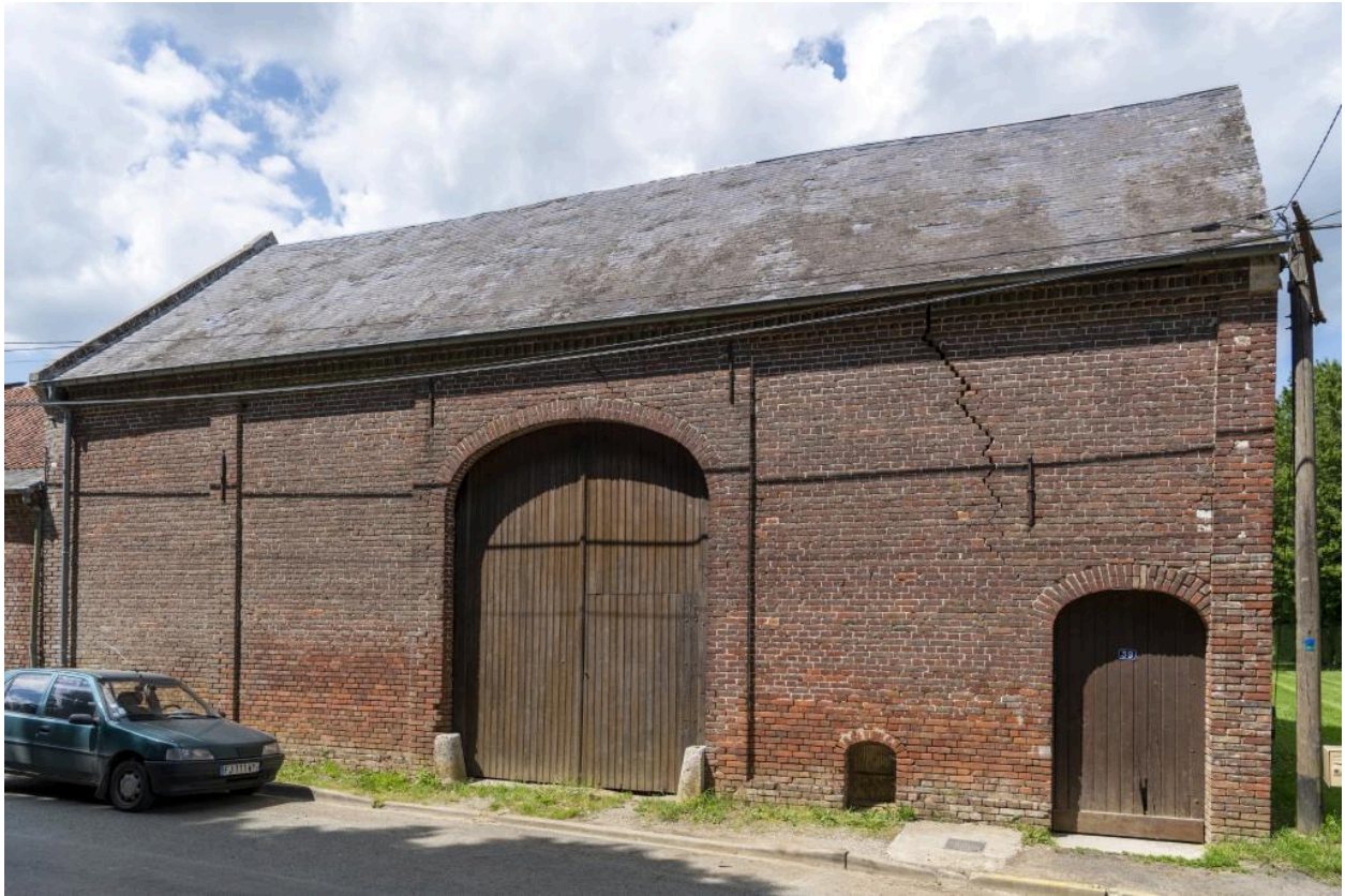
Grange avec entrée charretière et piétonne, n°39 Grande Rue, vue depuis le sud.
