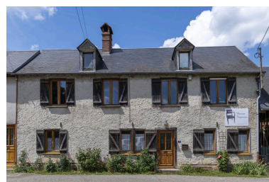
Logis sur rue n°17, ancien café, vue depuis le sud. Phot. Marc Kérignard IVR32_20216000633NUCA
