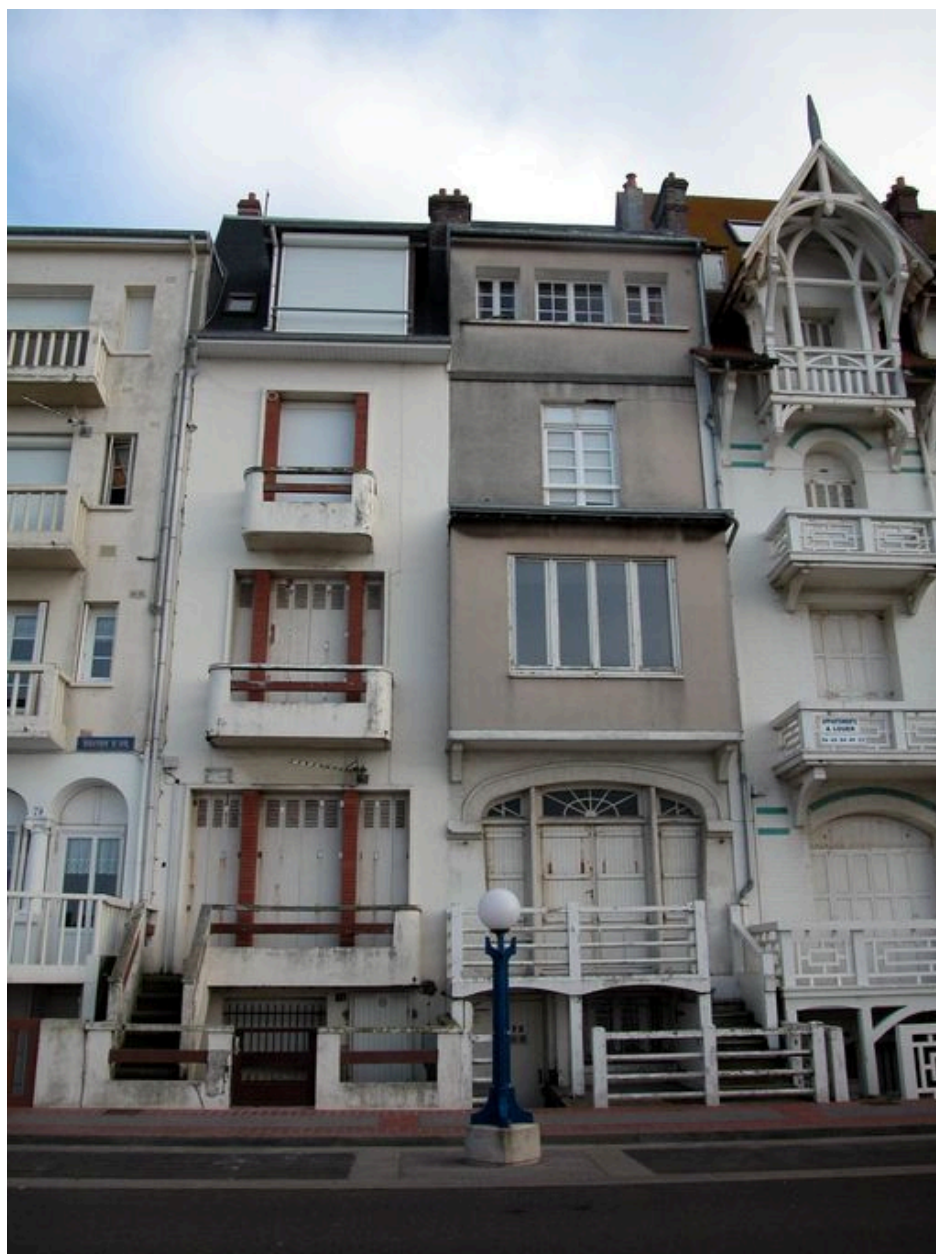
Elévation à 2x1 travée (71 et 72 esplanade du Général-Leclerc).
