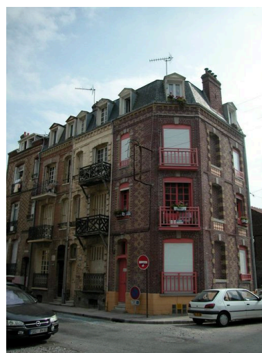
Le sous-sol à soupirail (16, 18 et 20 rue Julien-Hédin). Phot. Elisabeth Justome IVR22_20038005362NUCA
