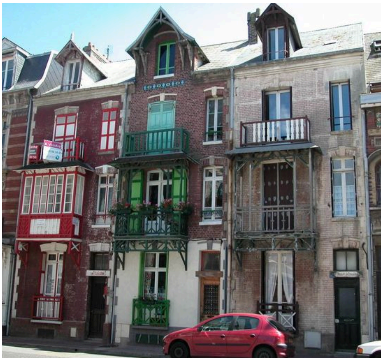
Elévation à 3x2 travées (10, 12, 14 avenue du Maréchal-Foch).
