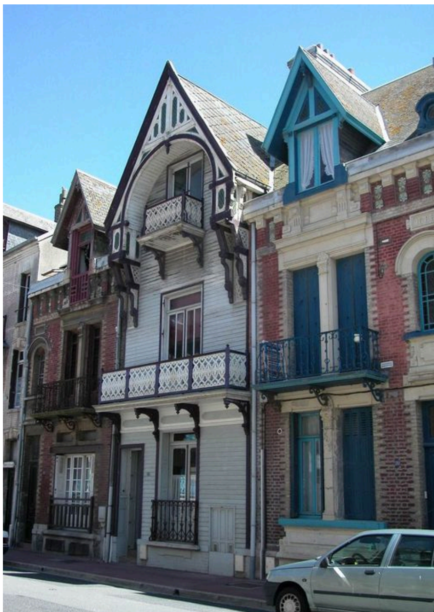
Le bardage bois et le style 'chalet' (18 avenue du Maréchal-Foch).
