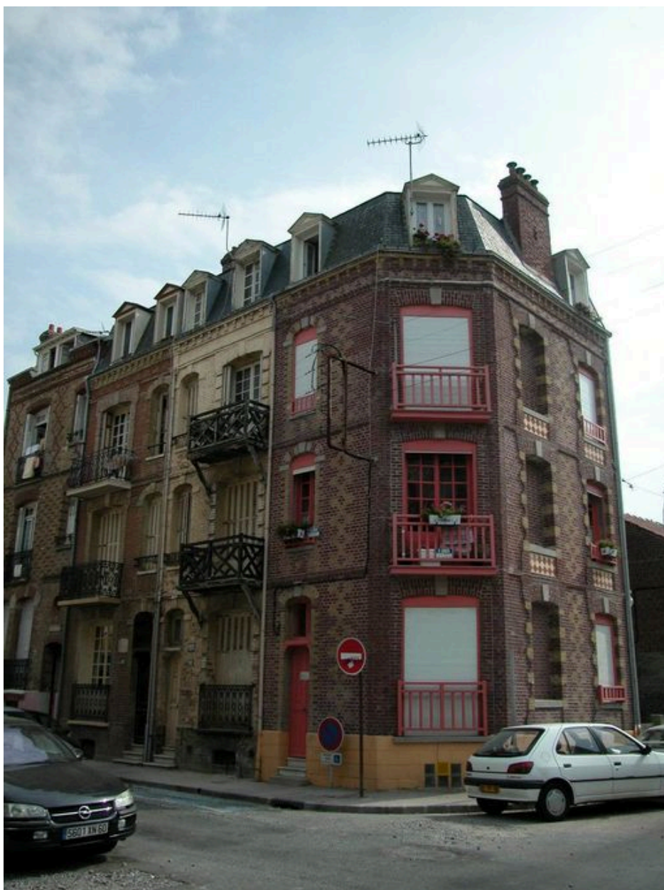
Le sous-sol à soupirail (16, 18 et 20 rue Julien-Hédin).
