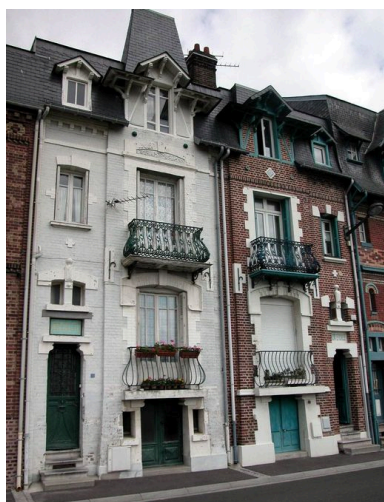
La surélévation de l'édifice par le sous-sol semi-enterré (25 et 27 rue Paul-Viguier). Phot. Elisabeth Justome IVR22_20038005235NUCA
