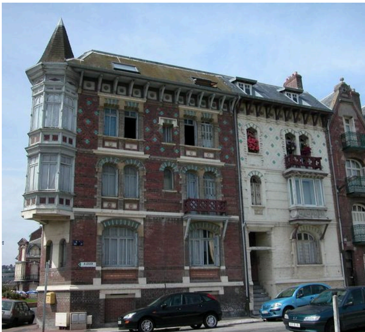
Sarrazine et Au Gui, avec deux traitements de façade différents (rue Sadi-Carnot).
