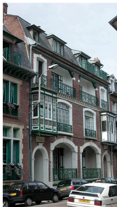
Le jeu des pleins et des vides : loggia et porche dans-oeuvre (14 et 16 rue Raspail).
