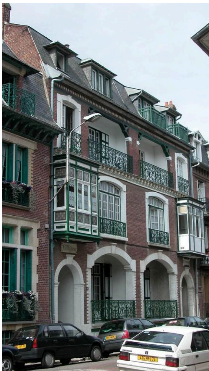
Le jeu des pleins et des vides : loggia et porche dans-oeuvre (14 et 16 rue Raspail).
