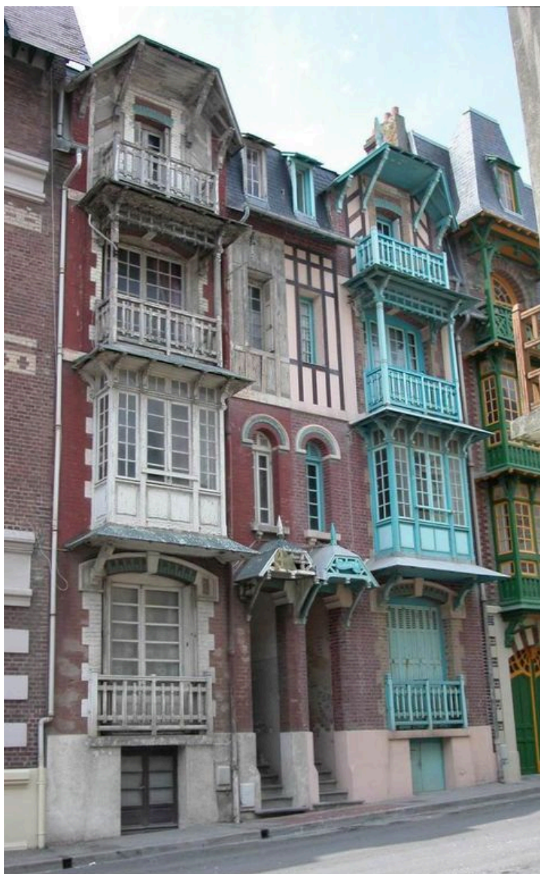
Maison avec faux pan de bois en partie supérieure du mur (8 et 10 rue Faidherbe).
