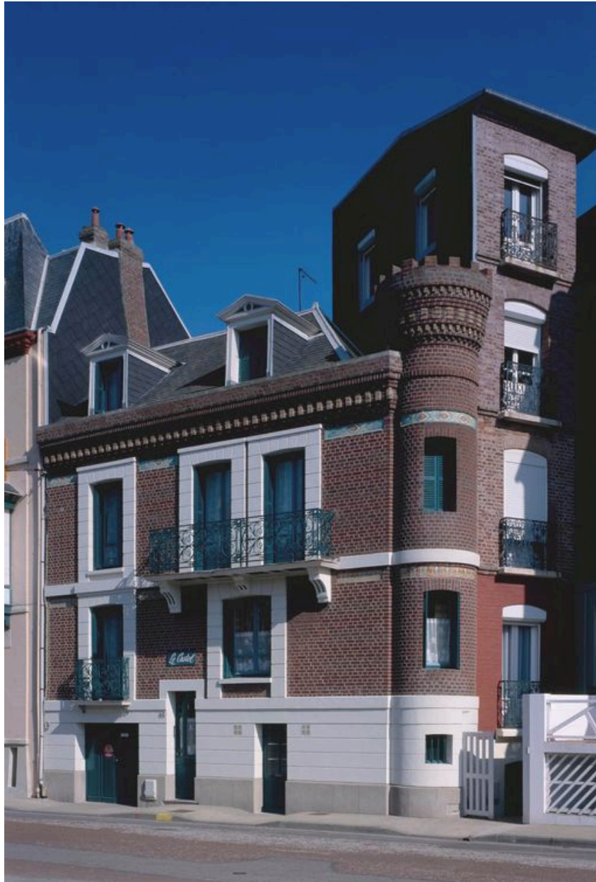
La tourelle crénelée, évocation du style médiéval (65 rue Henri-Leboeuf).
