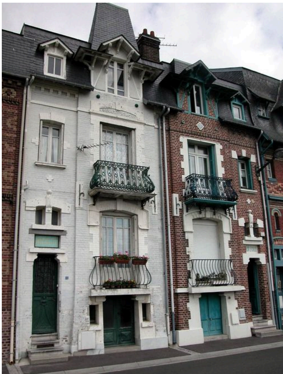
La surélévation de l'édifice par le sous-sol semi-enterré (25 et 27 rue Paul-Viguer).
