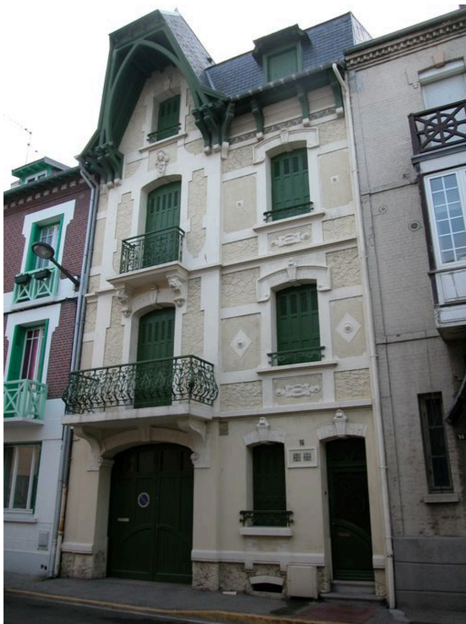
Cas singulier de garage dans-oeuvre (16 rue Faidherbe).
