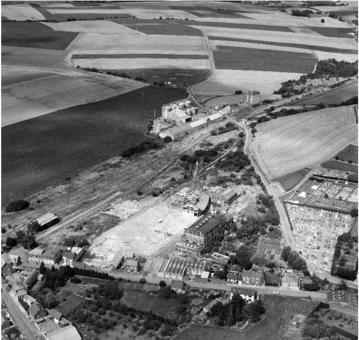
Vue aérienne, flanc sud-ouest.
