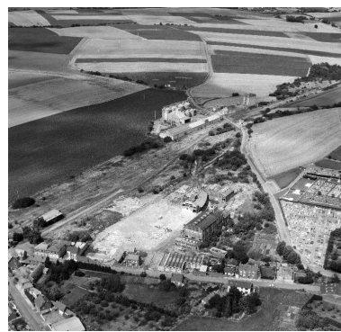
Vue aérienne, flanc sud-ouest. Phot. Phot'R IVR22_19888001289P
