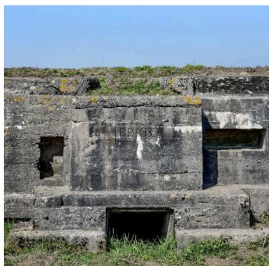
Élévation sud : Banquette de tir encadrée de niches à munition. Au niveau du sol, la resserre à mitrailleuse
