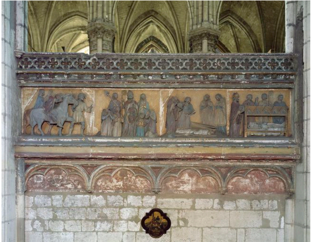
Vue de la deuxième travée nord.
