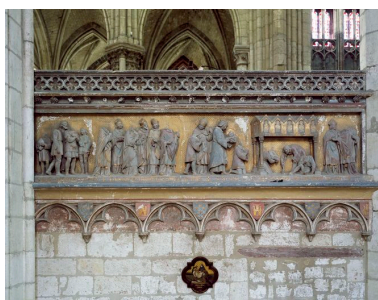
Vue de la première travée nord. Phot. Thierry Lefébure IVR22_20090200219VA
