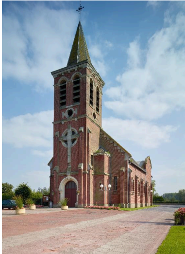
Vue générale. Phot. Pierre Thibaut IVR31_20155901594NUCA
