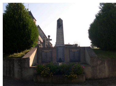
Le monument aux morts, Cloquier à Saint-Acheul. Phot. Isabelle Barbedor IVR22_20078012850NUCA
