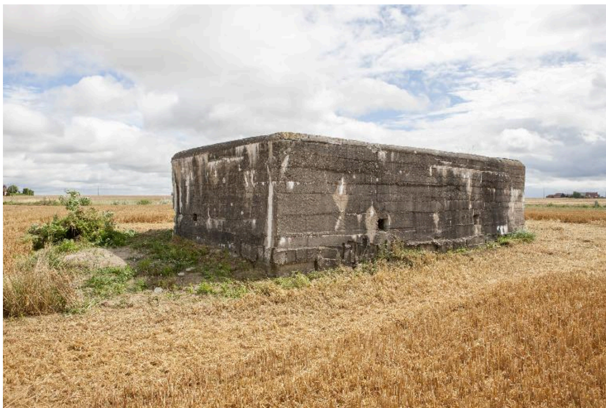
Vue générale vers le sud.
