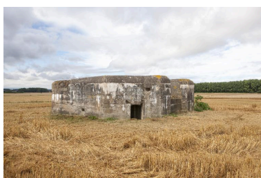
Vue générale vers l'ouest, entrée sud-est. Phot. Pierre Thibaut IVR32_20165901042NUCA
