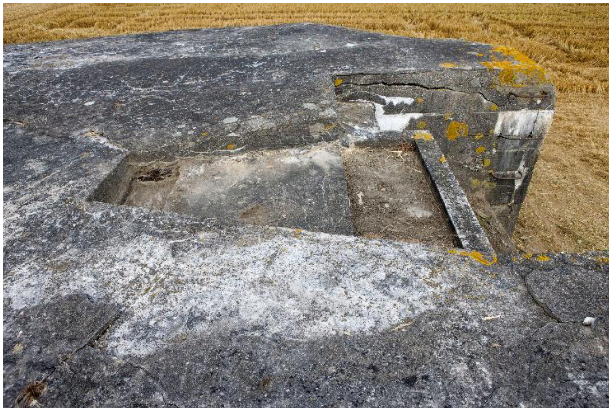
Blocage de l'affût de l'arme sur le toit, vers le nord-ouest
