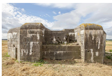
Élévation nord. La banquette de tir, accessible par échelons métalliques, comprend, au centre la position du mitrailleur et à droite, celle du servant
