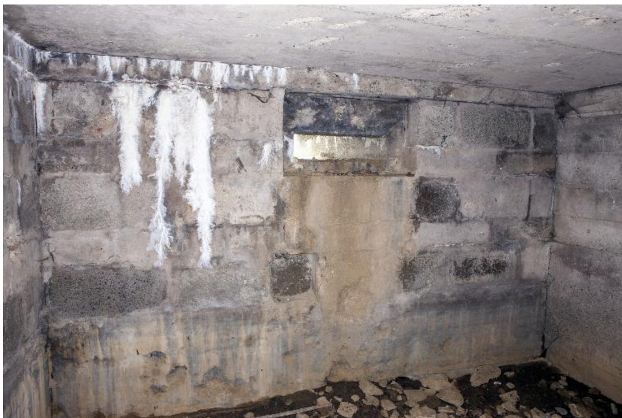
Salle est, créneau de tir vers l'est
