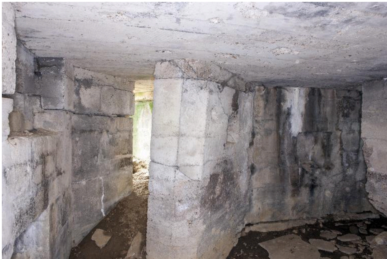
Vue intérieure,entrée en chicane ouest
