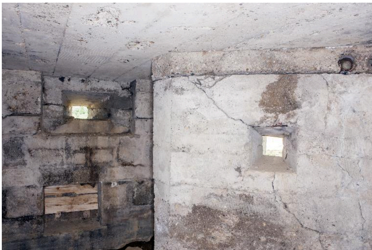
Entrée en chicane ouest et son créneaux de tir. A gauche, ouverture de tir de l'élévation ouest et sa niche à munitions (dessous)
