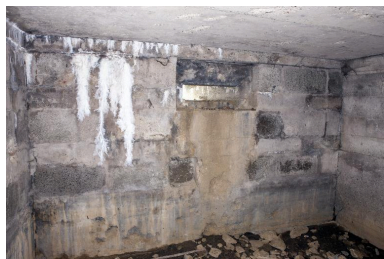
Salle est, créneau de tir vers l'est Phot. Pierre Thibaut IVR32_20165901058NUCA
