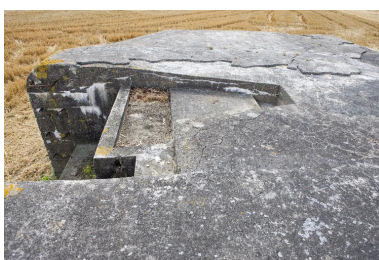
Blocage de l'affût de l'arme sur le toit, vers le sud-est Phot. Pierre Thibaut IVR32_20165901050NUCA
