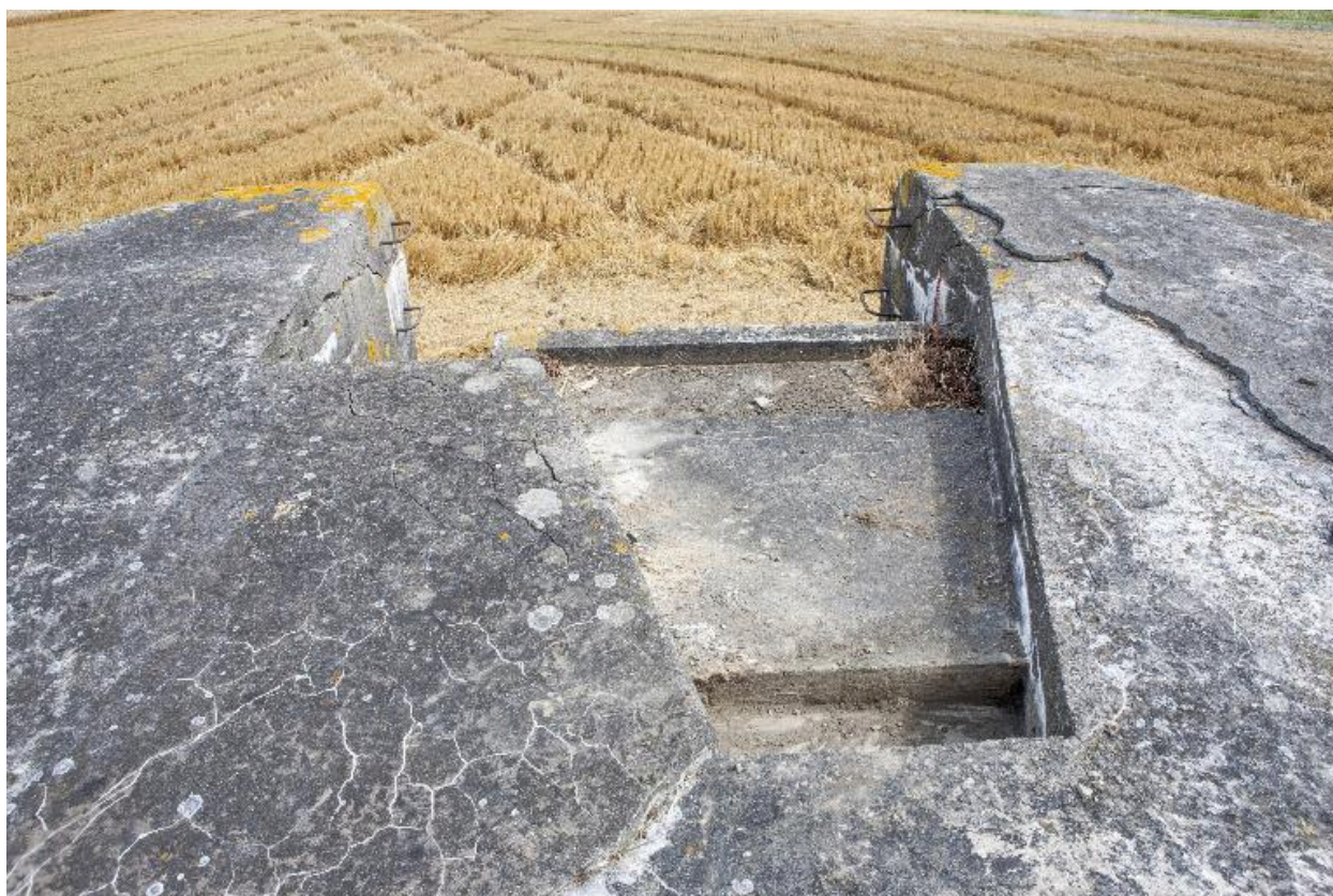
Blocage de l'affût de l'arme sur le toit, vers sud
