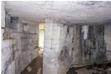
Vue intérieure, entrée en chicane ouest Phot. Pierre Thibaut IVR32_20165901055NUCA
