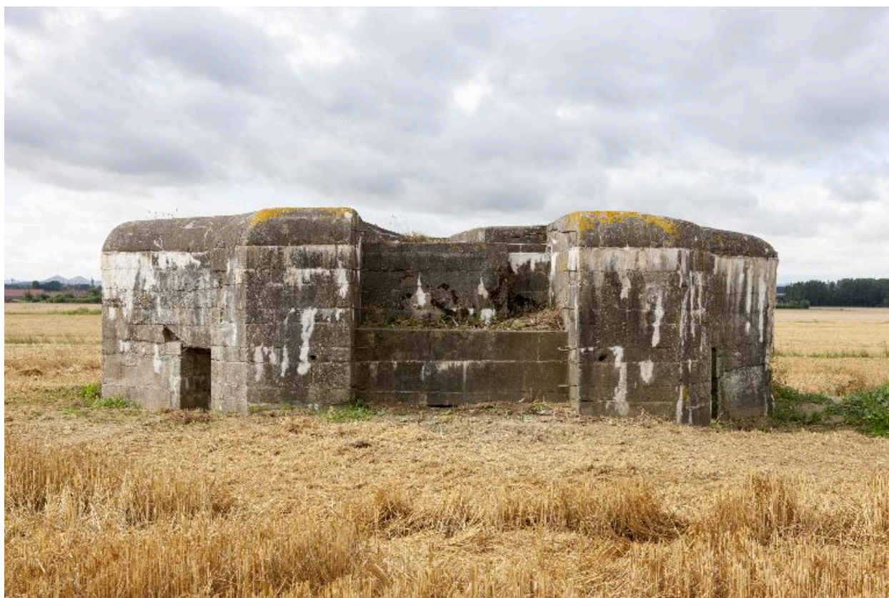
Elévation nord. On remarque les deux entrées latérales et la position de la mitrailleuse, au centre.
