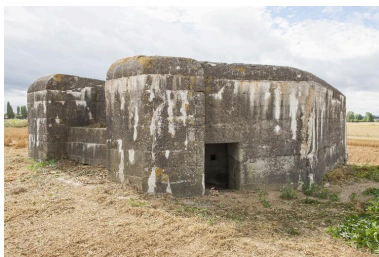
Vue générale, vers le sud. Entrée ouest dont on peut apercevoir le créneau de fusillade de l'entrée en chicane. A gauche, l'accès à la banquette de tir Phot. Pierre Thibaut IVR32_20165901045NUCA
