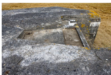
Blocage de l'affût de l'arme sur le toit, vers le nord-ouest Phot. Pierre Thibaut IVR32_20165901051NUCA
