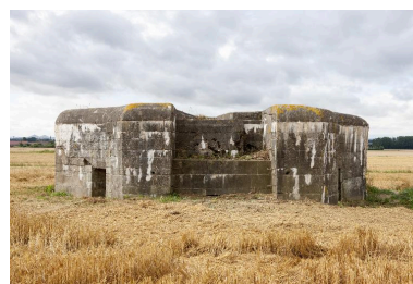
Élévation nord. On remarque les deux entrées latérales et la position de la mitrailleuse, au centre. Phot. Pierre Thibaut IVR32_20165901041NUCA
