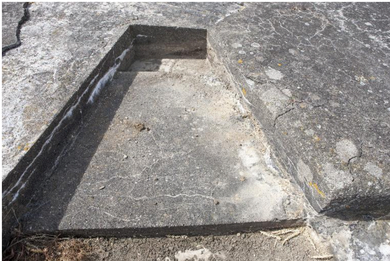
Blocage de l'affût de l'arme sur le toit, vers le nord
