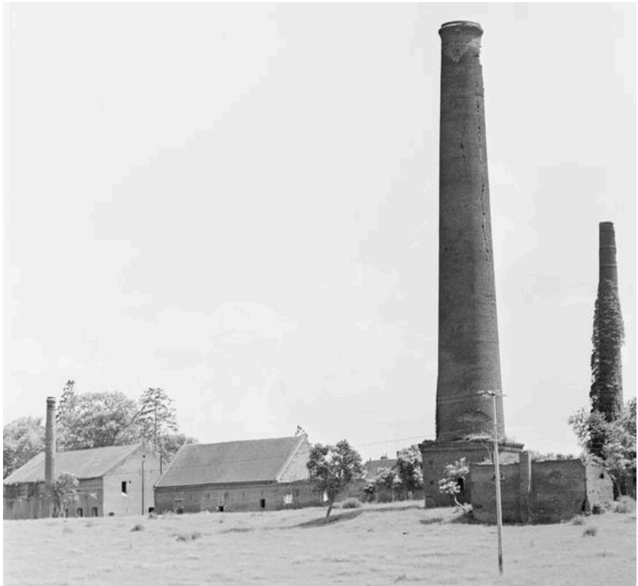
Cheminées d'usine, atelier de fabrication et remise.
