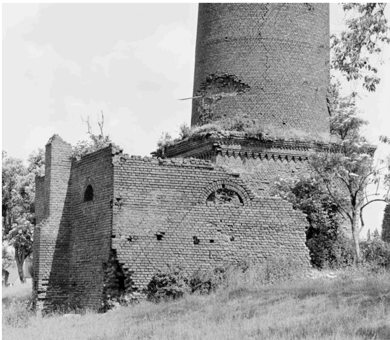
Socle de la cheminée d'usine.
