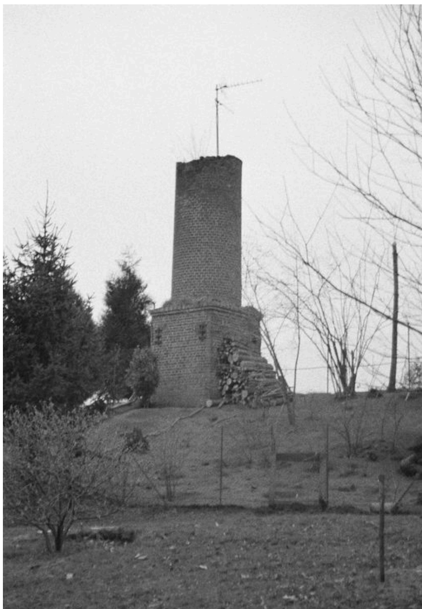
Vestiges de la cheminée détruite en 1918.
