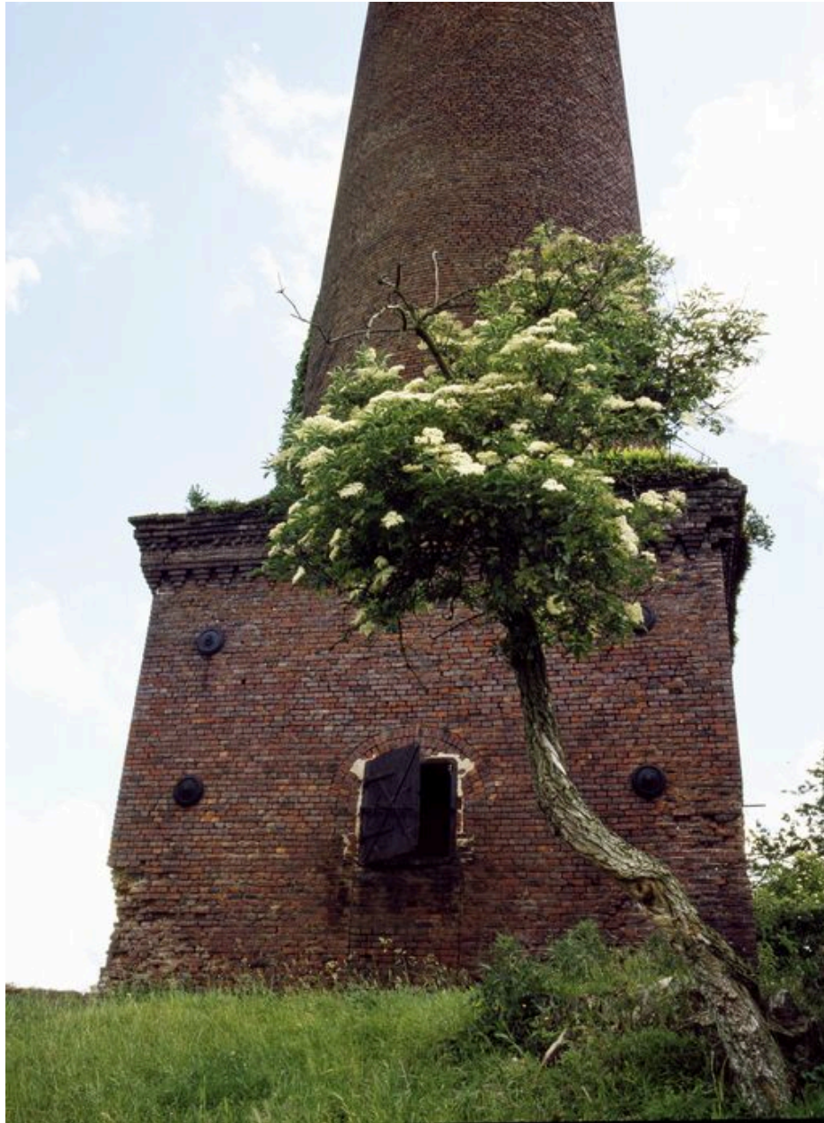
Socle d'une cheminée d'usine.
