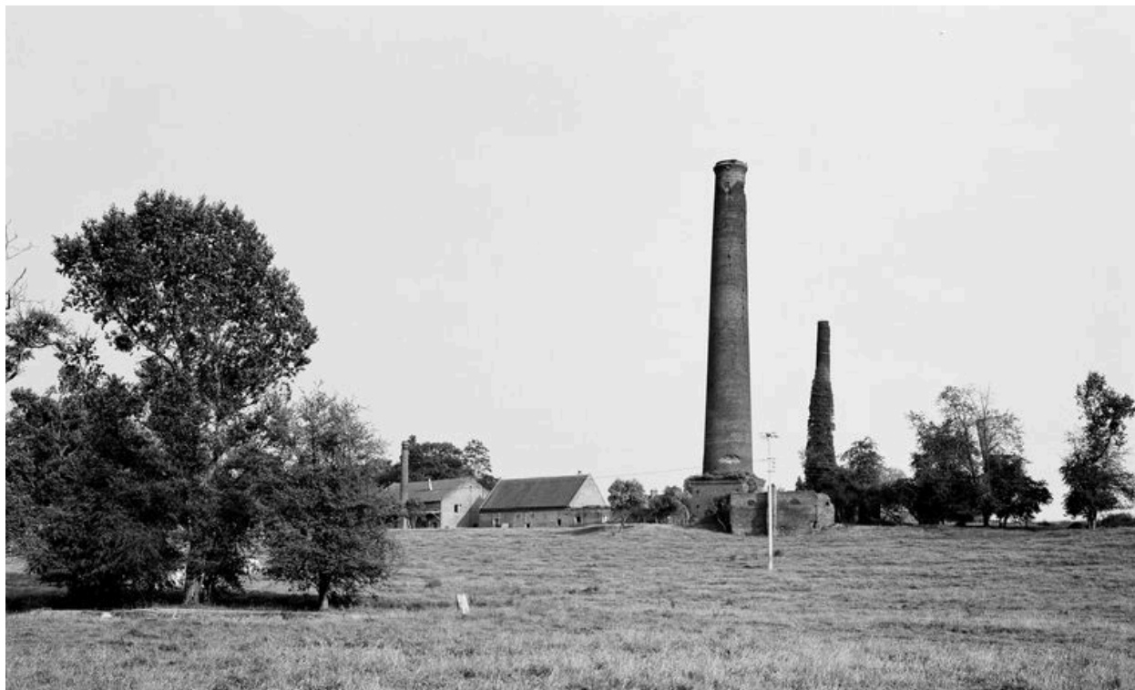
Vue générale nord.
