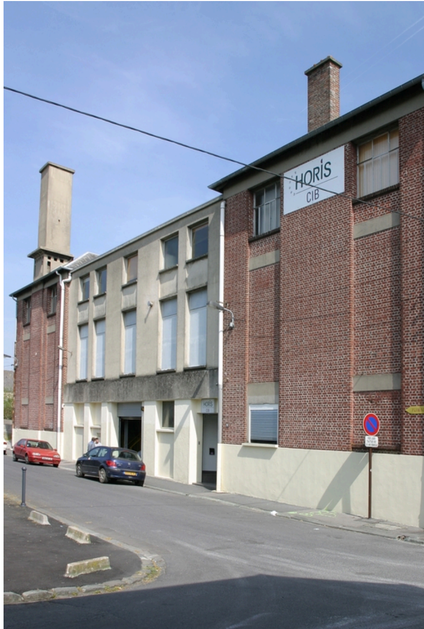
Façade des bureaux de l'usine (extension de 1982 au centre).
