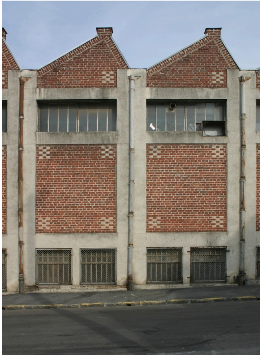
Détail des ateliers, rue Félix-Davin.
