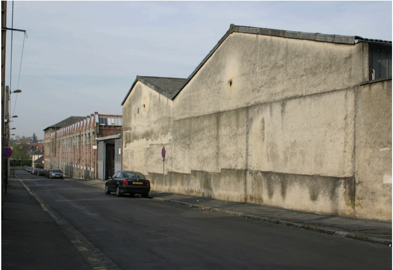
Extensions de l'usine des années 1960.
