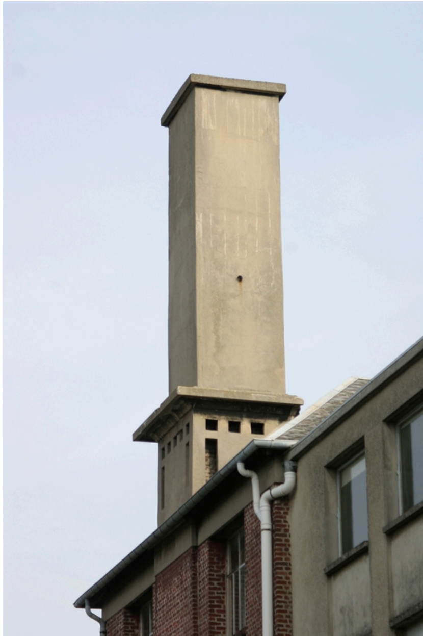
Détail d'une des cheminées surplombant les bureaux.
