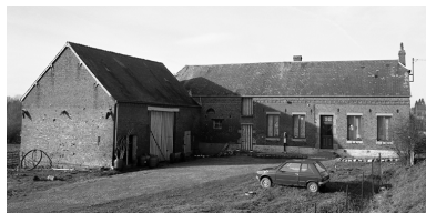
Vue générale depuis l'est. Phot. Thierry Lefébure IVR22_19960200938X
