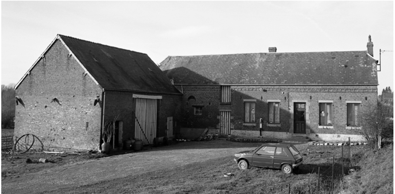
Vue générale depuis l'est.
