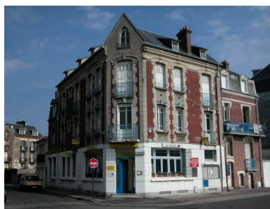
Vue d'ensemble depuis la rue Marcel-Holleville. Phot. Elisabeth Justome IVR22_20038005361NUCA
