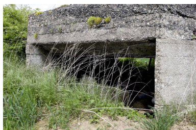
Entrée de la chambre de tir Phot. Jean-Marc Ramette IVR31_20145904335NUCA
