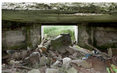
Chambre de tir, vers le front Phot. Jean-Marc Ramette IVR31_20145904334NUCA
