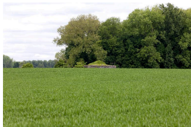
Vue générale vers le nord-ouest Phot. Jean-Marc Ramette IVR31_20145904326NUCA
