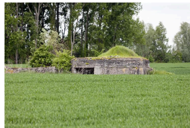
Vue générale vers le nord-ouest Phot. Jean-Marc Ramette IVR31_20145904328NUCA
