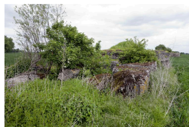
Vue latérale vers l'est. Soute à munitions Phot. Jean-Marc Ramette IVR31_20145904336NUCA
