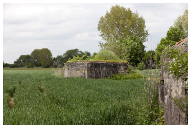
Vue latérale, vers le sud-ouest depuis le blockhaus 205 Phot. Jean-Marc Ramette IVR31_20145904330NUCA
