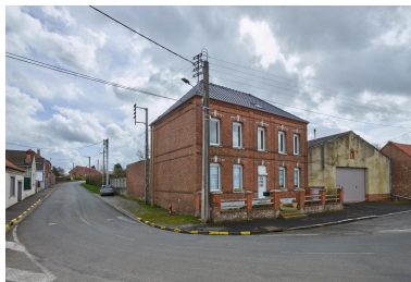
Vue de trois quarts de l'élévation antérieure prise depuis le nord.
