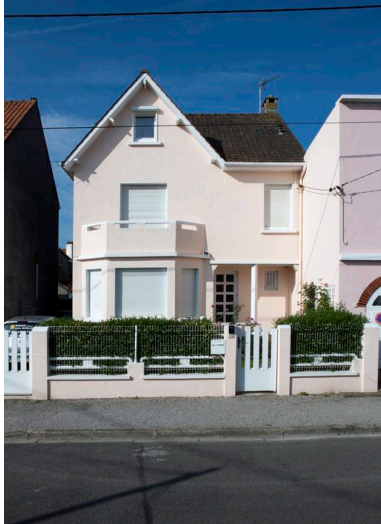
Vue générale. Phot. Pierre Thibaut IVR31_20146202218NUCA
