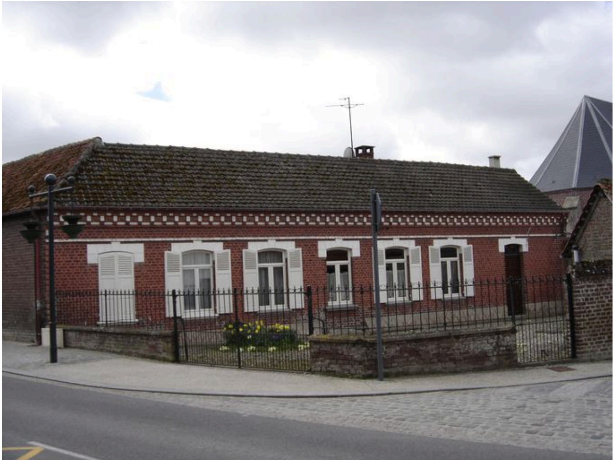
Vue générale du logis depuis la rue.
