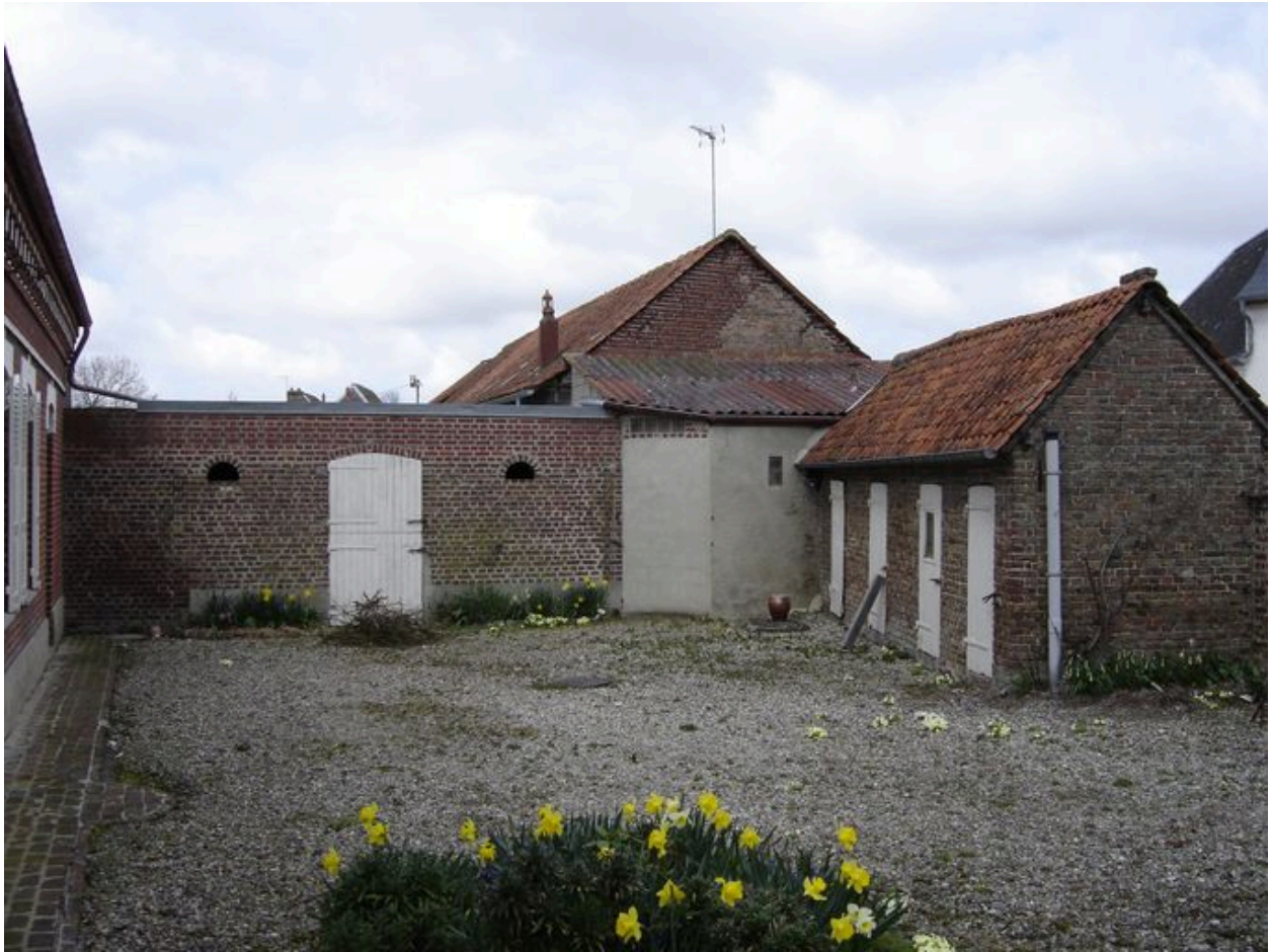
Vue des dépendances (étables à cochons et écuries) situées au nord de la propriété.
