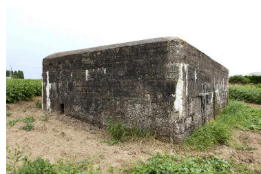
Vue de trois-quarts, vers le sud. En bas, à gauche, un créneau de fusillade Phot. Jean-Marc Ramette IVR31_20145904966NUCA
