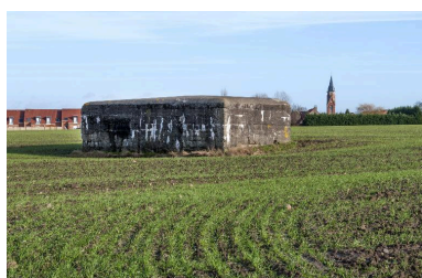
Vue de trois-quarts arrière, vers l'est Phot. Jean-Marc Ramette IVR31_20145904972NUCA
