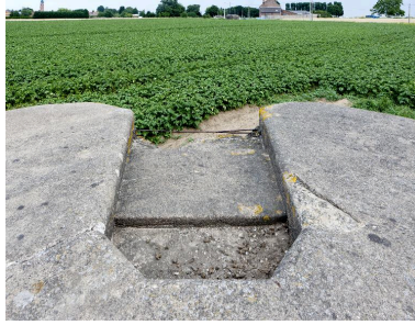
Cuve à mitrailleuse. Vue longitudinale, vers l'est Phot. Jean-Marc Ramette IVR31_20145904968NUCA
