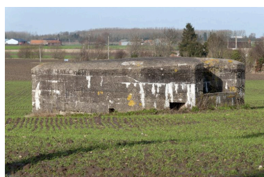
Vue de trois-quarts vers le nord. L'accès sur le pan coupé ainsi que le créneau de fusillade, à gauche, sont partiellement enterrés. Phot. Jean-Marc Ramette IVR31_20145904970NUCA
