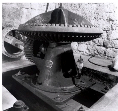
La turbine. Phot. Thierry Lefébure IVR22_20026001109X
