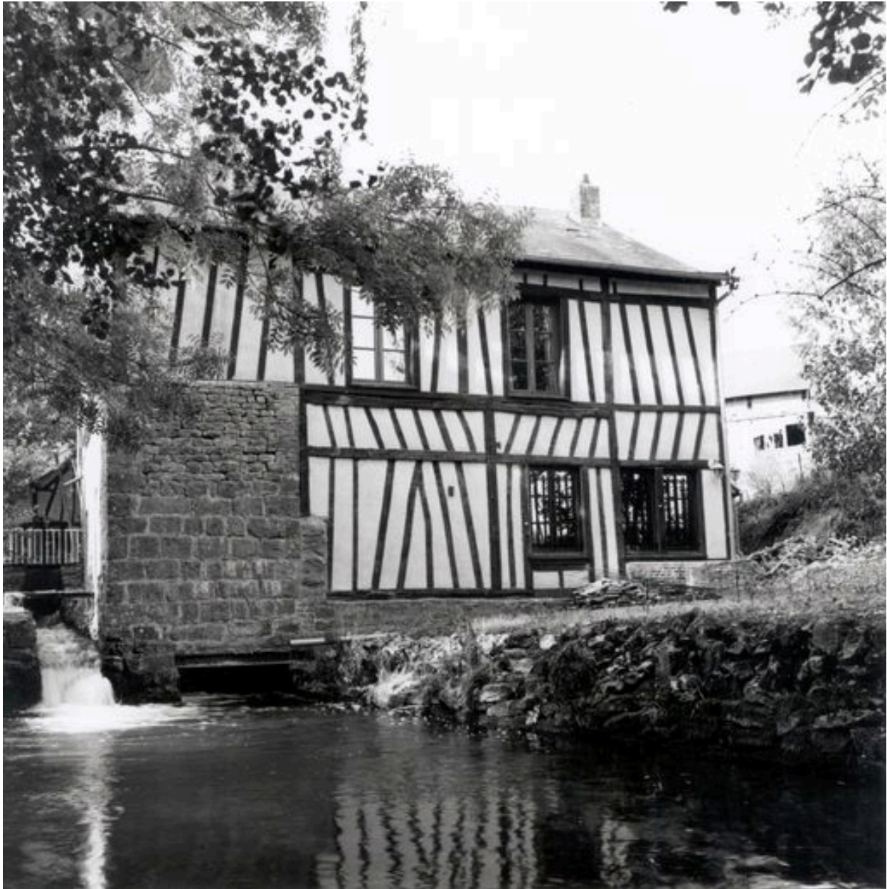
Vue d'ensemble de la façade postérieure.
