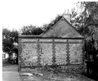
Mur de clôture portant les initiales B L en fers d'ancrages Phot. Thierry Lefébure IVR22_20026001101X
