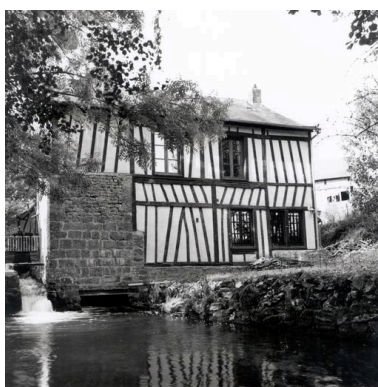
Vue d'ensemble de la façade postérieure. Phot. Thierry Lefébure IVR22_20026001102X
