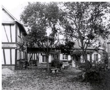
Vue d'ensemble de la façade sur cour du moulin. Phot. Thierry Lefébure IVR22_20026001106X
