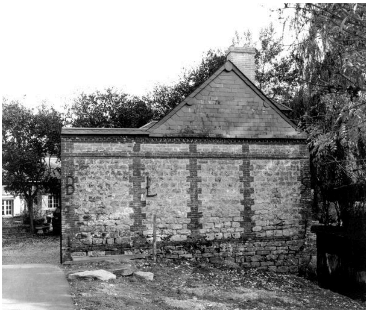
Mur de clôture portant les initiales B L en fers d'ancrages
