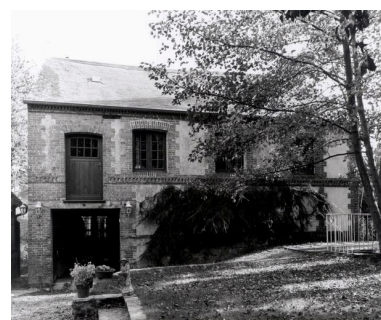
Vue d'ensemble de la façade sur cour du moulin. Phot. Thierry Lefébure IVR22_20026001104X
