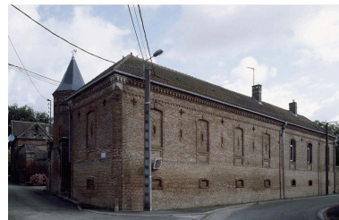
Vue générale depuis la rue de la Ville. Phot. Marie-Laure Monnehay-Vulliet IVR22_20098000258XA
