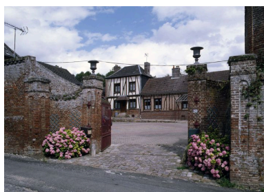
Portail, logis et logement en fond de cour. Phot. Marie-Laure Monnehay-Vulliet IVR22_20098000262XA
