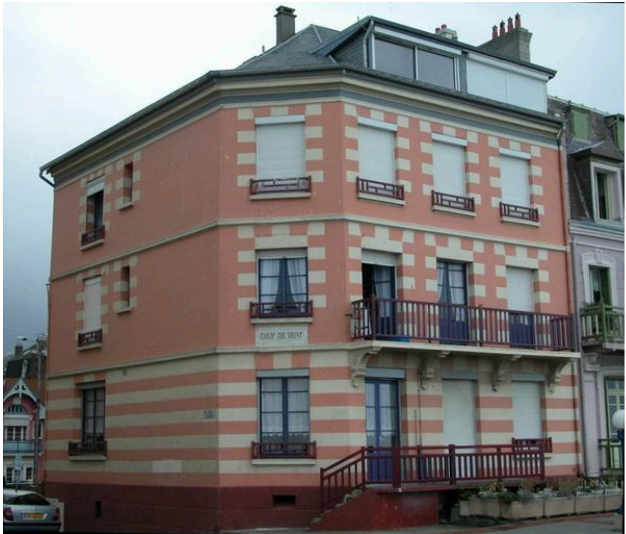
Vue d'ensemble depuis l'esplanade.
