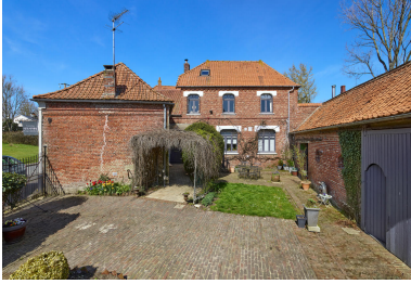
Vue générale depuis la cour. Phot. Thierry Lefébure IVR32_20236200326NUCA
