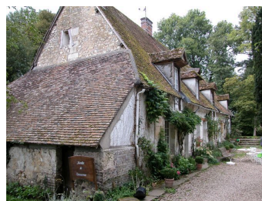
Vue générale. Phot. Bertrand Fournier IVR22_20046003001NUCA
