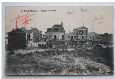
Les anciennes Galeries de la Mer, 'Marcelo-Maria-Janito, détruites (AD Somme). Phot. Justome Elisabeth (reproduction) IVR22_20058003563NUCAB
