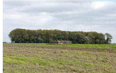
Vue générale vers le sud-est Phot. Jean-Marc Ramette IVR31_20145904085NUCA
