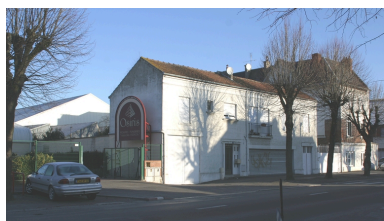
De gauche à droite : les ateliers et le magasin industriel (arrière- plan), les bureaux, et les logements.
