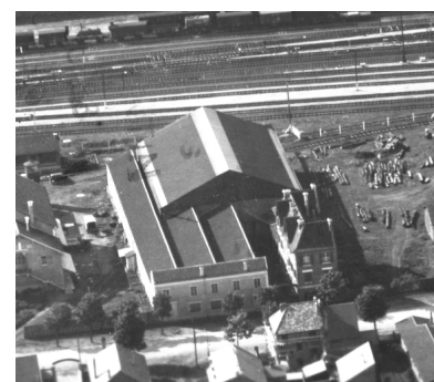
Vue aérienne du site, vers 1925 (BM Saint-Quentin). Phot. Pillet Frédéric IVR22_20050206291NUCAB
