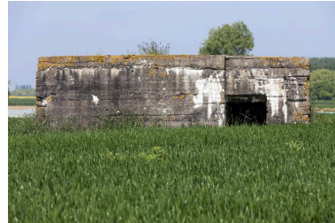
Entrée sur l'élévation nord-est Phot. Jean-Marc Ramette IVR31_20145905457NUCA
