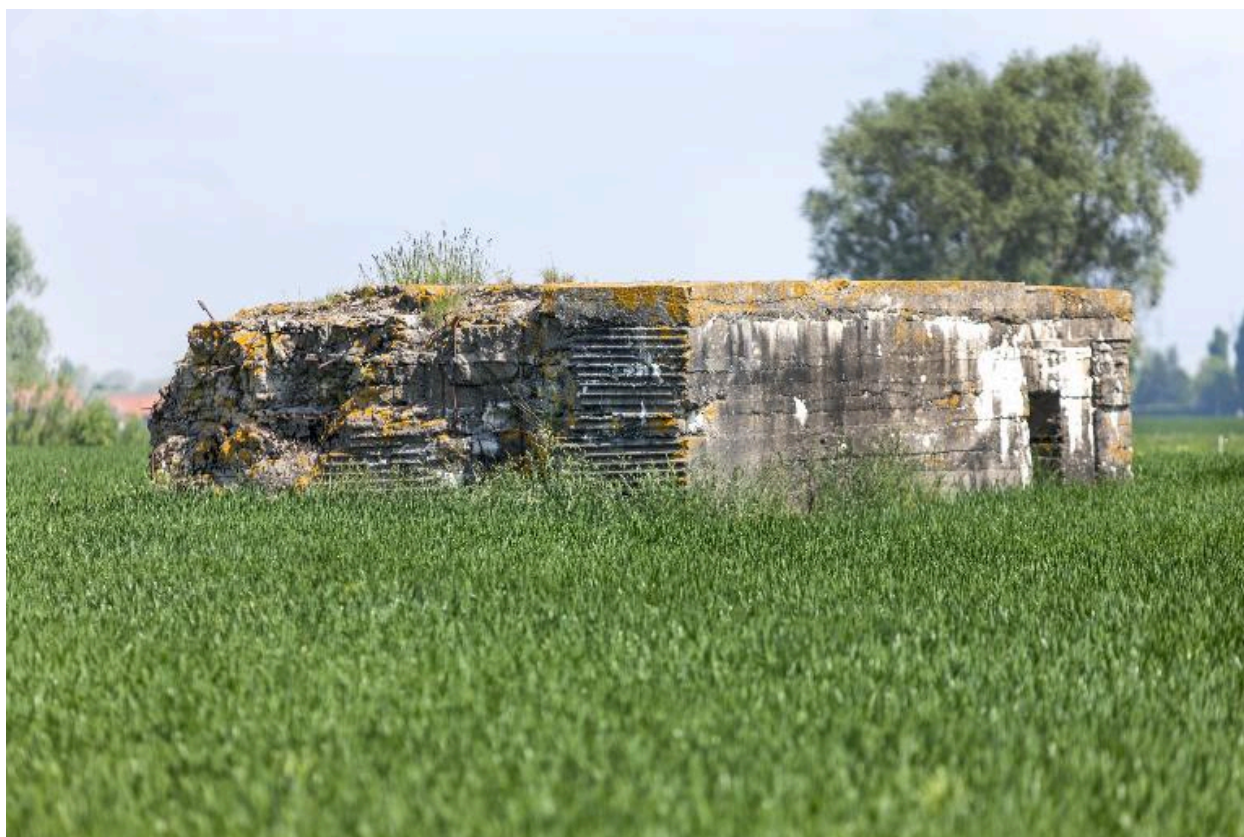
Vue de trois-quarts vers le nord
