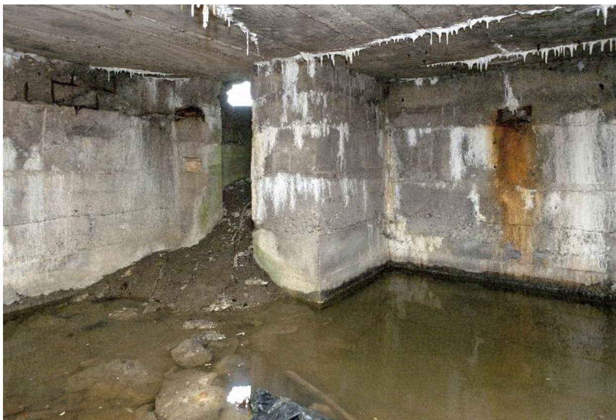
Vue intérieure. A gauche l'accès au poste d'observation.
