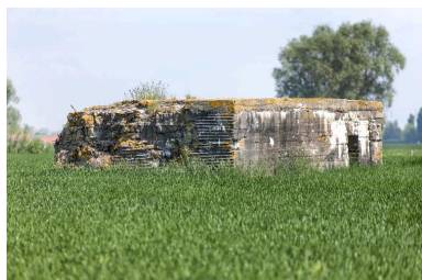
Vue de trois-quarts vers le nord Phot. Jean-Marc Ramette IVR31_20145905461NUCA
