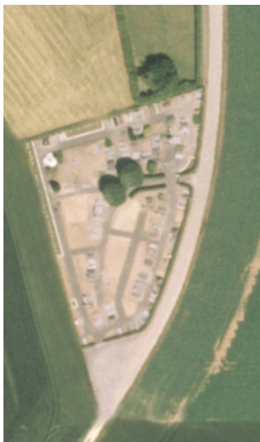
Vue aérienne. Phot. Phot. Inv. IVR22_20058010442NUCA
