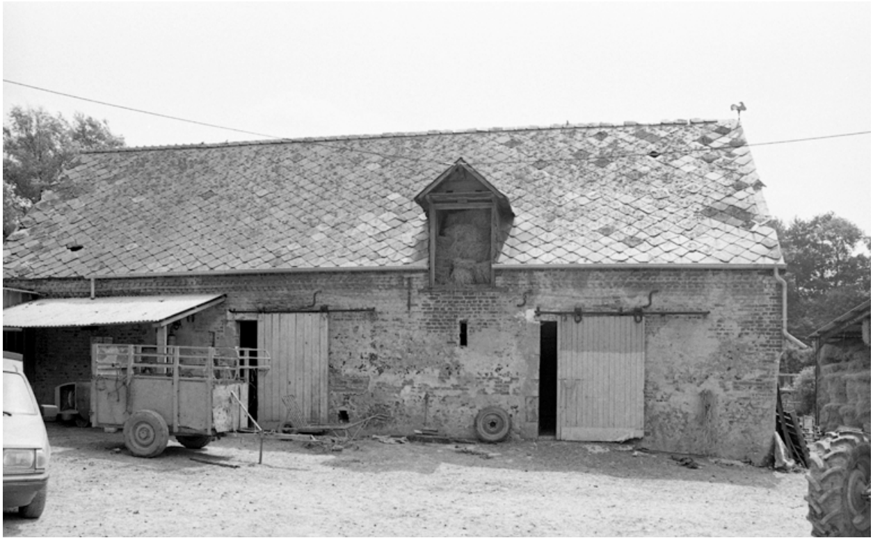
Élévation sur cour de l'étable sud-est.
