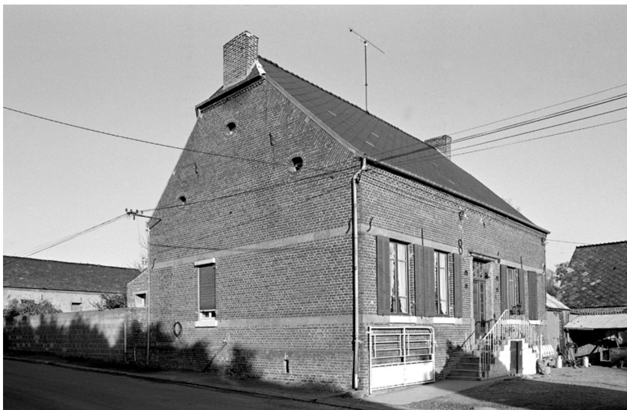
Vue d'ensemble ouest du logis édifié en 1861.
