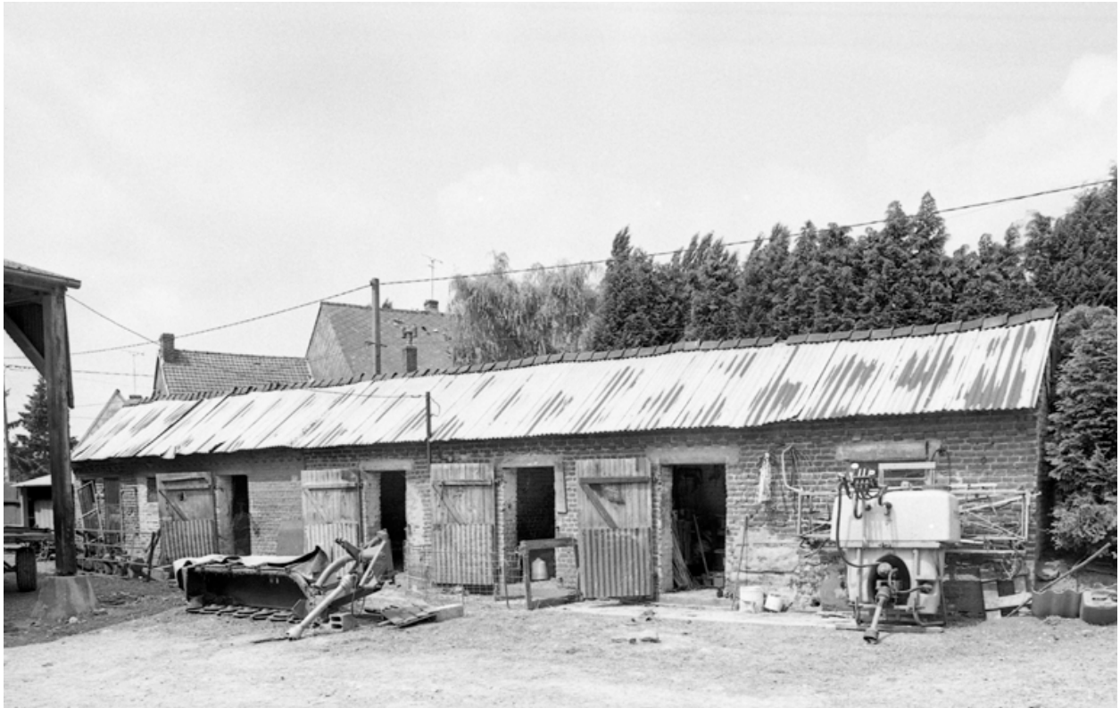
Vue d'ensemble de l'élévation sur cour de l'étable ouest.
