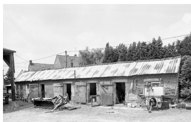
Vue d'ensemble de l'élévation sur cour de l'étable ouest. Phot. Thierry Lefébure IVR22_19920201336Z
