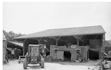
Vue d'ensemble de l'élévation sur cour de la grange. Phot. Thierry Lefébure IVR22_19920201337Z
