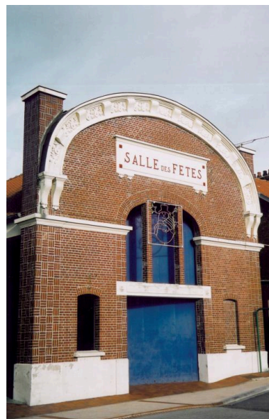
Vue générale. Phot. Gilles-Henri Bailly IVR22_20158005778NUCA
