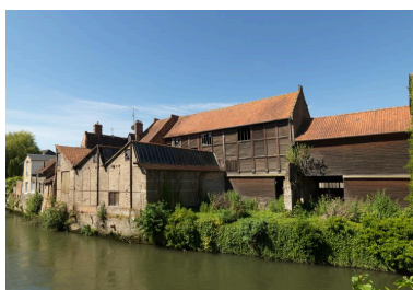
Vue générale depuis la rive droite de la Somme. Phot. Marie-Laure Monnehay-Vulliet IVR32_20188000346NUC2A
