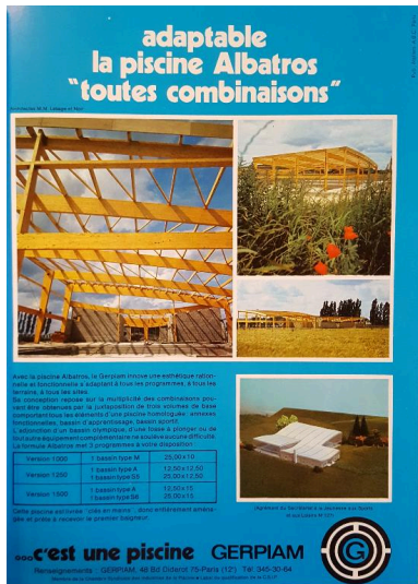
Publicité GERPIAM présentant la piscine "Albatros", publiée dans la revue Piscines, hors-série "Piscines publiques", 1972. Les photos montrent la construction d'une piscine "Albatros", avec son ossature en bois préfabriqués, et ses murs montés en matériaux traditionnels (parpaings).
