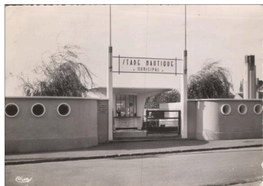
Entrée du stade nautique municipal de Caudry, carte postale, vers 1950 (coll. part.). Phot. Laurence Schlosser (reproduction) IVR32_20175905012NUCA
