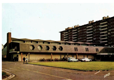
La piscine de Ronchin (réalisation du projet-type agréé n°122 de l'architecte Jean Doldourian), carte postale, vers 1975 (coll. part.). Phot. Laurence Schlosser (reproduction) IVR32_20175905072NUCA
