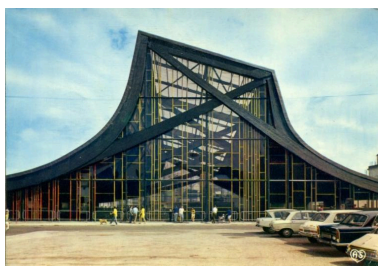
Vue de la façade vitrée et de la charpente en bois lamellé-collé de la piscine de Berck-Plage, carte postale, vers 1970 (coll. part.). Phot. Laurence Schlosser (reproduction) IVR32_20176205071NUCA
