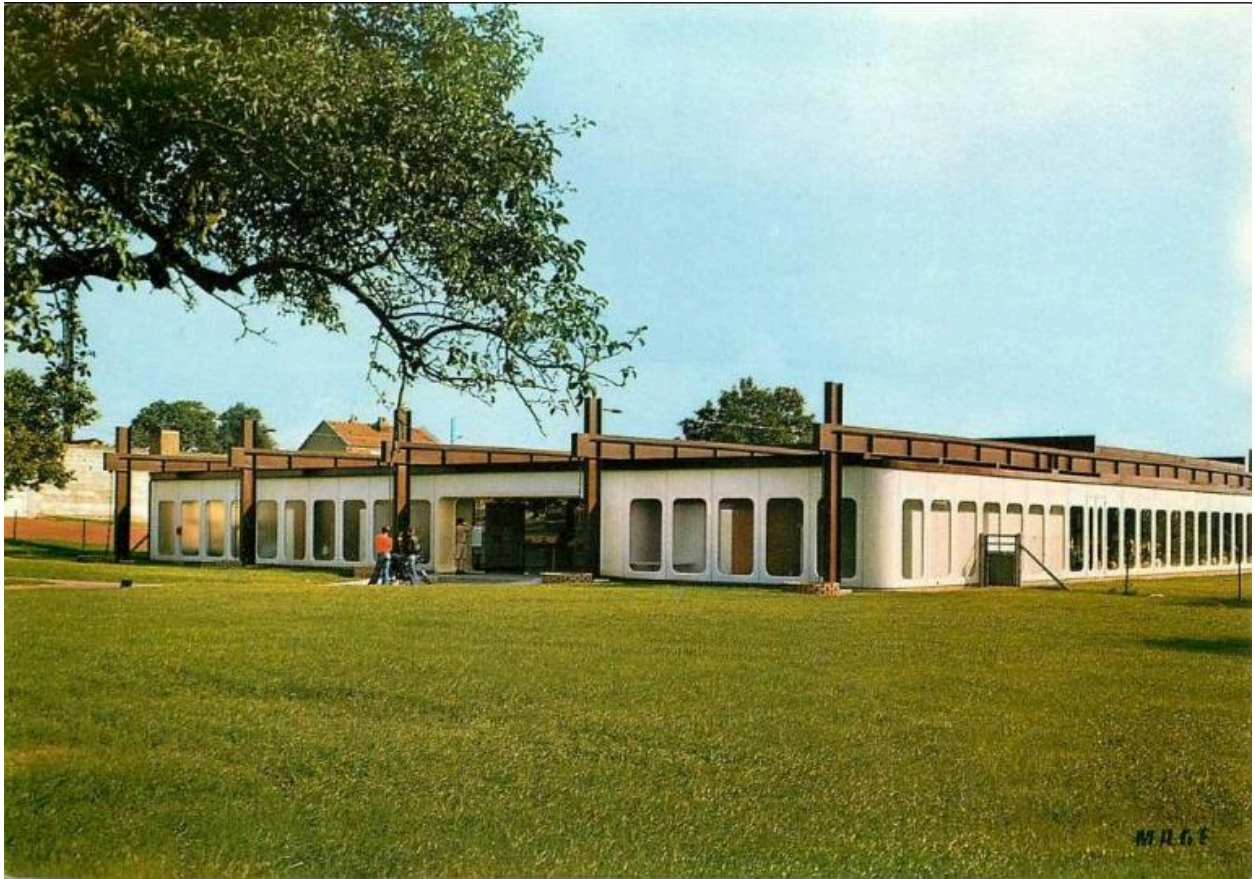
La piscine transformable "Rieuse" de Corbie (architecte : Michel Cornuéjols), carte postale, vers 1975 (coll. part.).
