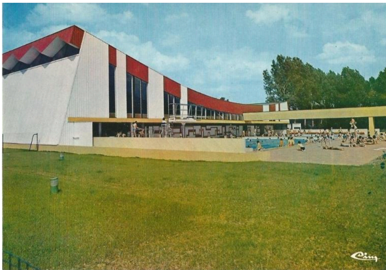
La piscine transformable Ombelia à Quiévrechain en position ouverte (été), vers 1980 (coll. part.).
