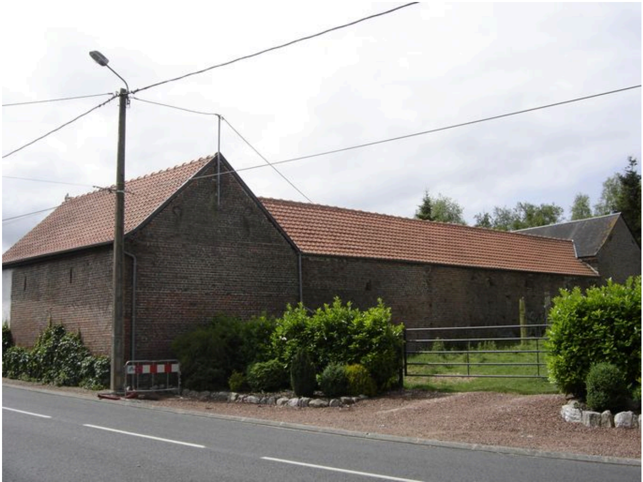
Vue générale latérale.
