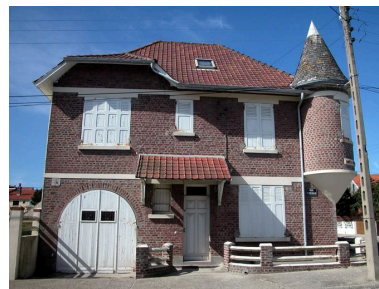
Elévation latérale, rue Pierrain. Phot. Elisabeth Justome IVR22_20058002754NUCA
