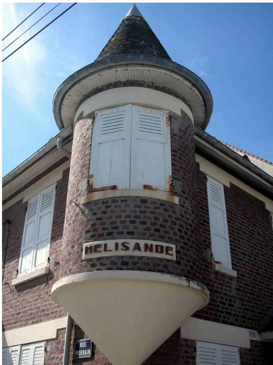
Détail de la tourelle d'angle en surplomb.
