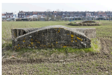
Vue vers le nord-est. D'avant en arrière : casemates a et b Phot. Jean-Marc Ramette IVR31_20145905573NUCA
