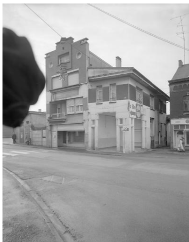
Vue générale des bains-douches. Phot. Olivier Marlard IVR31_19925901948V
