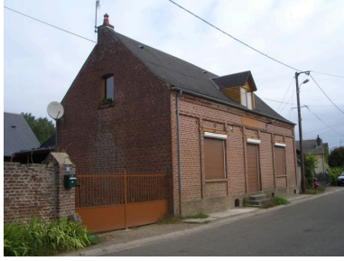
Vue générale. Phot. Inès Guérin IVR22_20078005135NUCA
