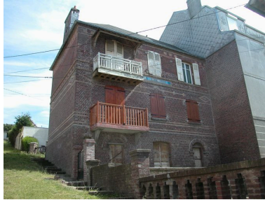
Vue de l'élévation postérieure, côté mer, depuis la rue Dingleton. Phot. Elisabeth Justome IVR22_20048001552NUCA
