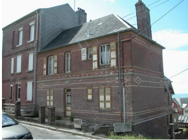
Vue d'ensemble de l'élévation antérieure, depuis la rue Gros. Phot. Elisabeth Justome IVR22_20048001551NUCA
