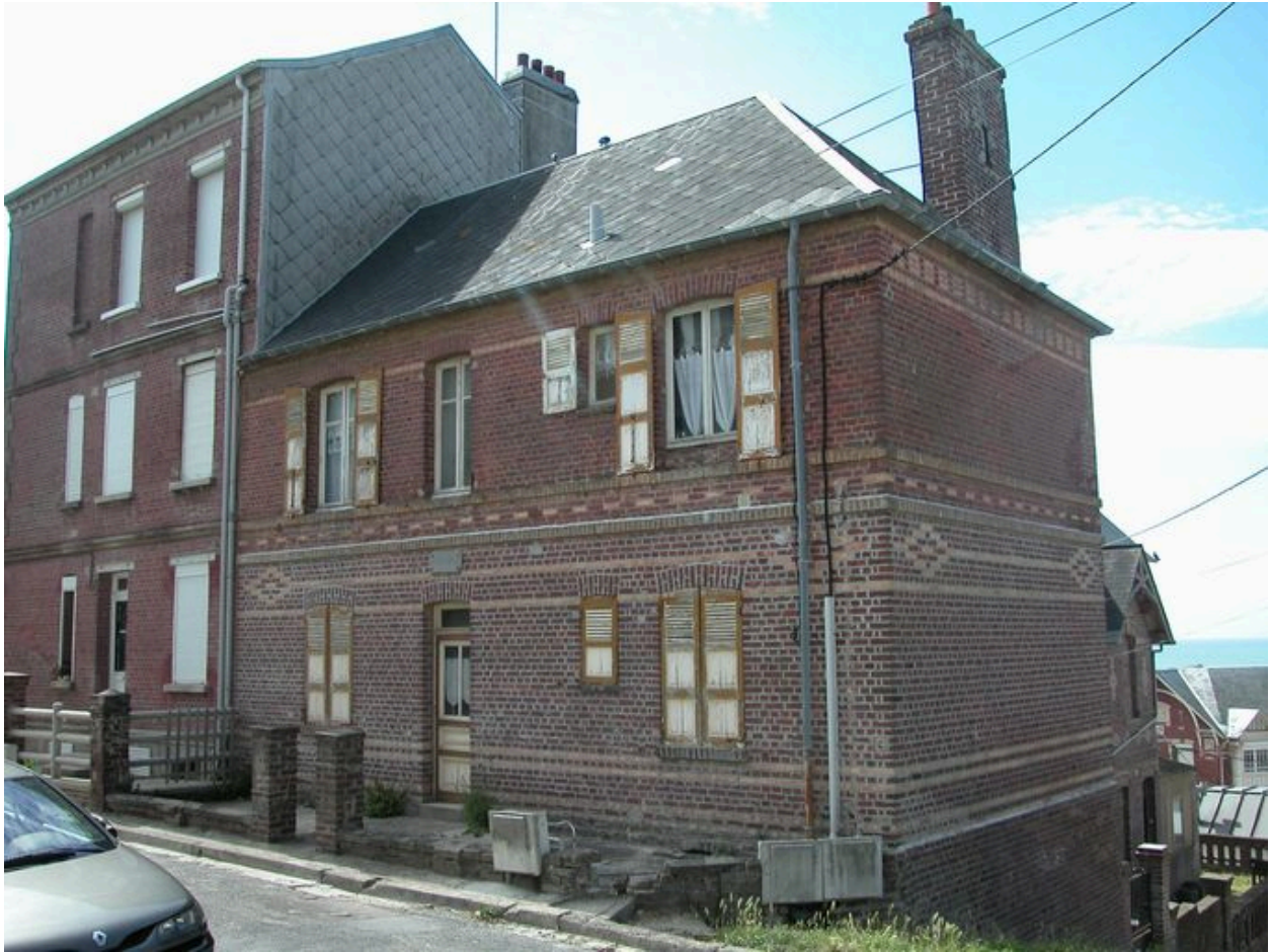
Vue d'ensemble de l'élévation antérieure, depuis la rue Gros.
