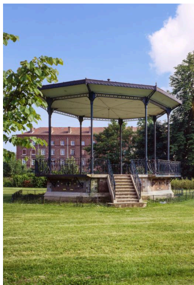
Vue du kiosque.
