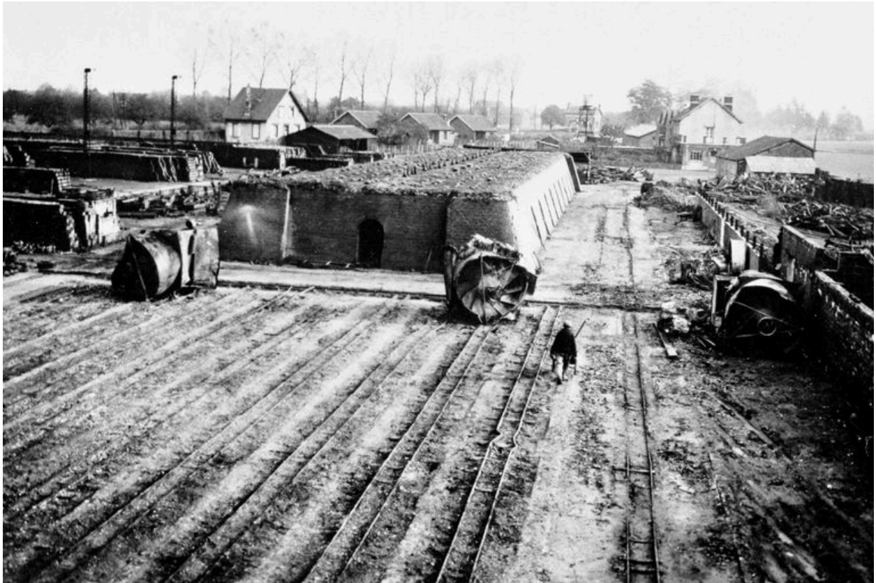
REMY. Briqueterie Bohy. Vestiges des rails de séchage des briques et du four, après l'incendie du 19 septembre 1934 (AP).
