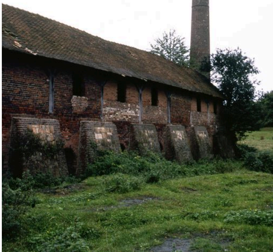
REMY. Vue d'ensemble de la briqueterie Dupuis.
