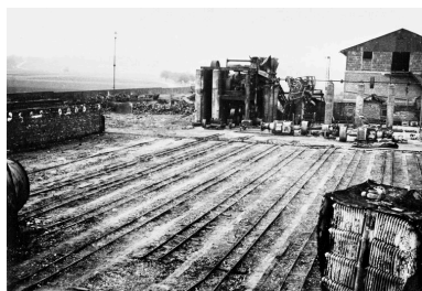
REMY. Briqueterie Bohy. Vestiges des rails de séchage des briques après l'incendie du 19 septembre 1934 (AP). Phot. Thierry Lefébure IVR22_20006000208XB
