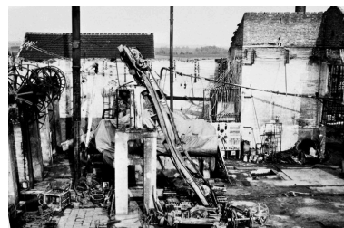
REMY. Briqueterie Bohy, après l'incendie du 19 septembre 1934 (AP). Phot. Thierry Lefébure IVR22_20006000207XB
