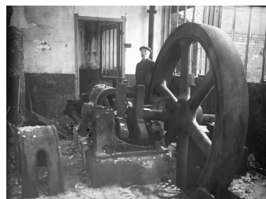
Salle des machines : machine à gaz pauvre Duplex détruite, 1919 (AD Aisne). Phot. Pillet Frédéric IVR22_20050205012NUCAB
