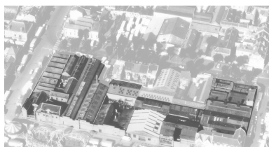
Vue aérienne de l'usine Maumaire en 1989, englobant le site originel de la fonderie Barré et Juranville et l'ancienne usine de Mesmay. Phot. Pillet Frédéric, Autr. Phot'R IVR22_20050205016NUCA
