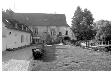
Le moulin côté sud, avec le vannage à droite, en 1996.
