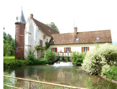
Vue générale, côté ouest.
