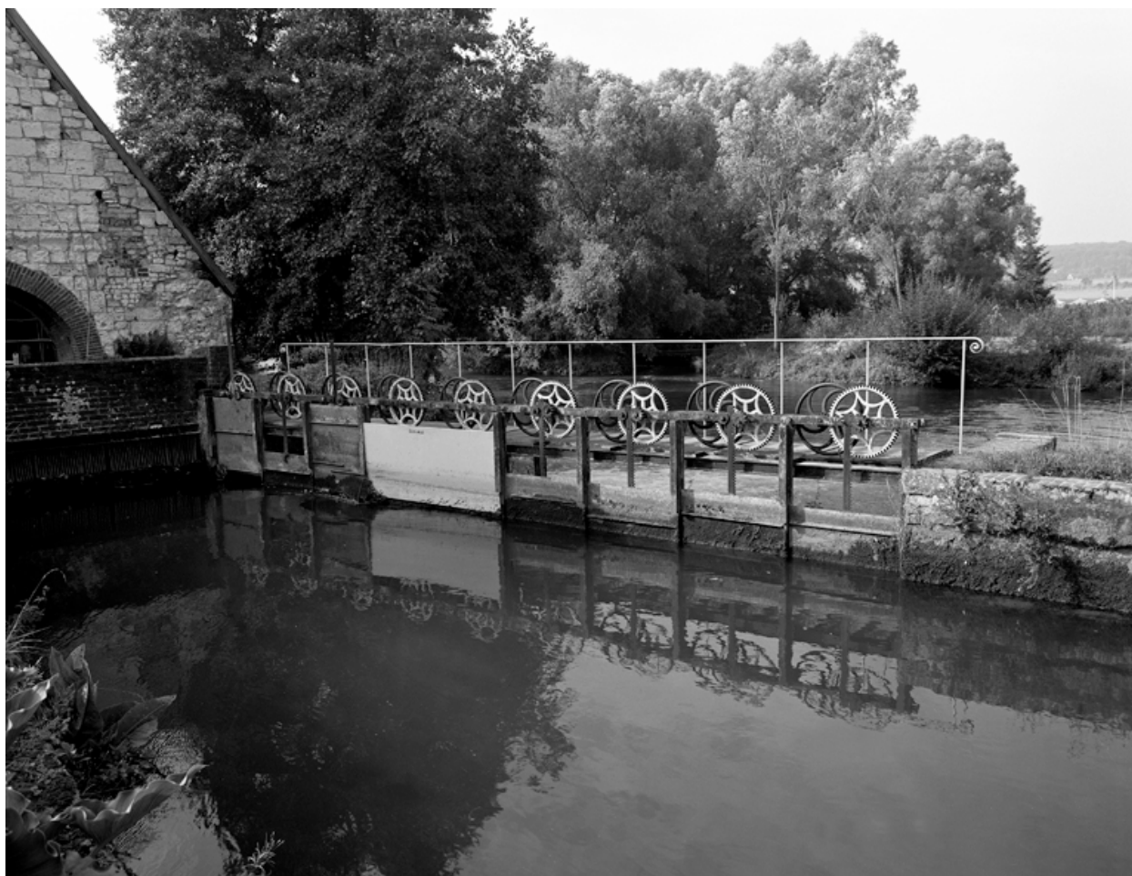
Détail du vannage et du bassin de retenue.
