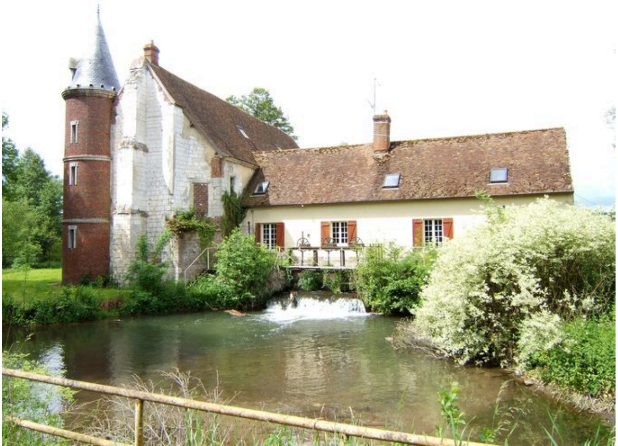
Vue générale, côté ouest.
