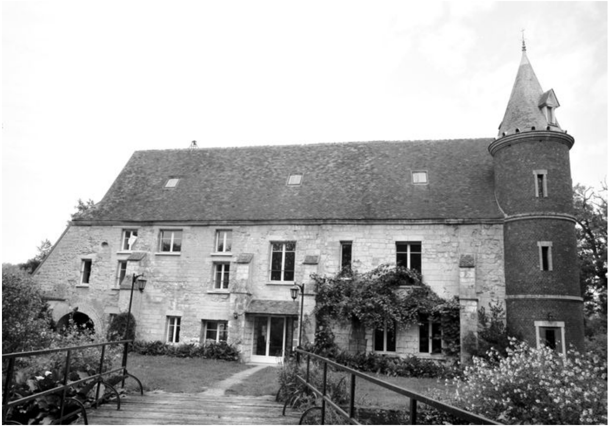
Vue générale du moulin, côté nord, en 1996.
