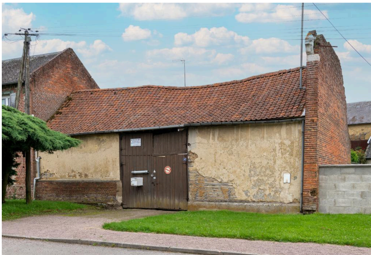
Grange sur rue d'une ancienne ferme, n°40 rue Principale, vue depuis l'est.
