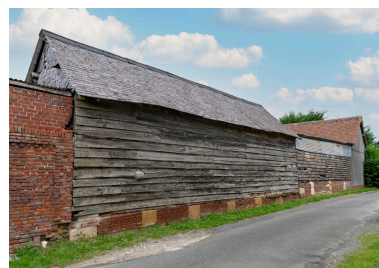
Bâtiment agricole essenté en blins de bois, n°45 rue Principale, vue depuis le sud-ouest. Phot. Marc Kérignard IVR32_20216000859NUCA
