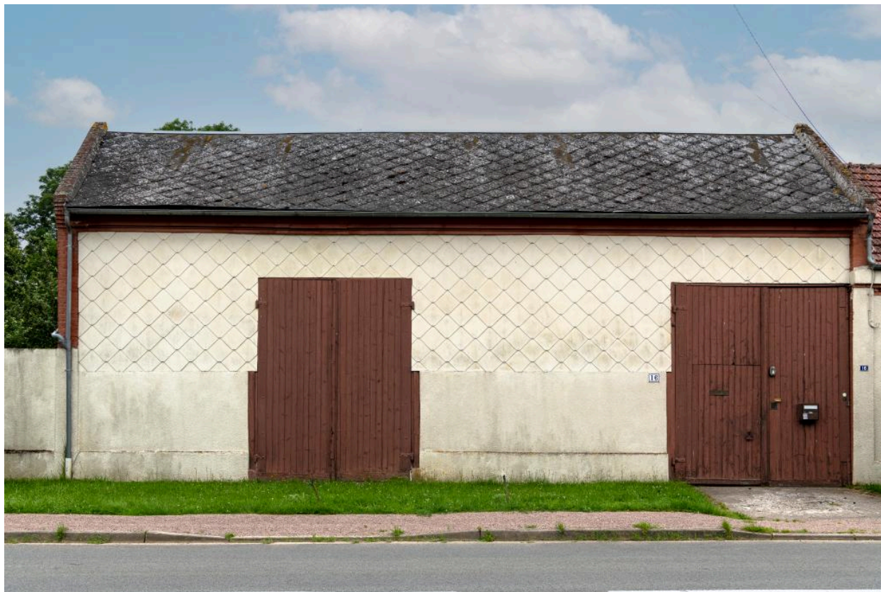
Ancienne grange n°16 rue Principale, vue depuis l'est.
