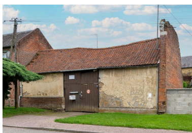
Grange sur rue d'une ancienne ferme, n°40 rue Principale, vue depuis l'est. Phot. Marc Kérignard IVR32_20216000863NUCA
